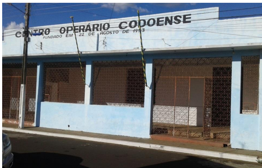
Fachada do Centro Operário Codoense no ano de 2018.
