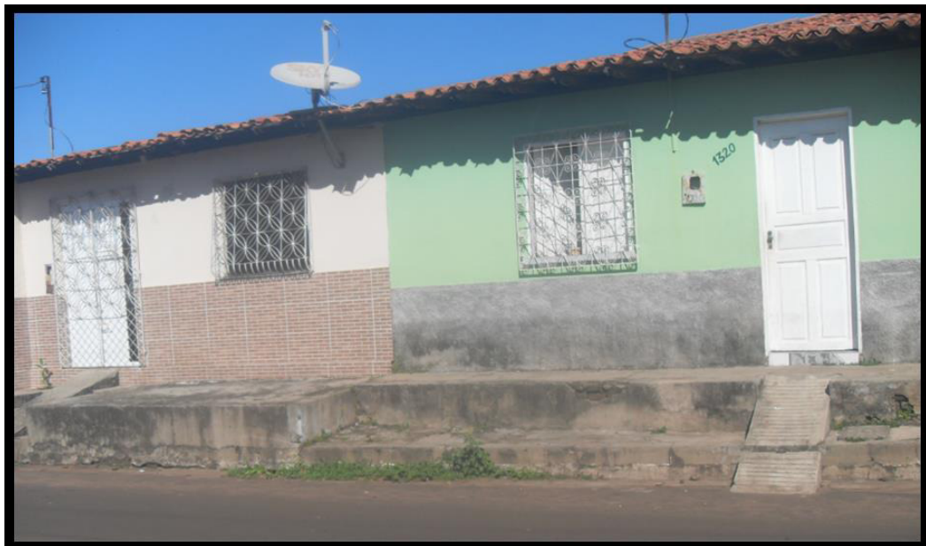
Figura 03: residências protegidas com grades de ferro para evitar os riscos de arrombamentos e assaltos.
