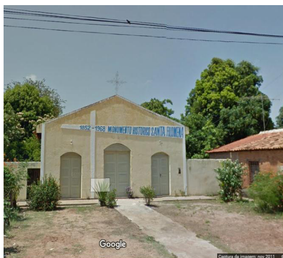
Figura 11: Igreja Santa Filomena (fundação em 1852). Fonte: Google Earth, 2018.
