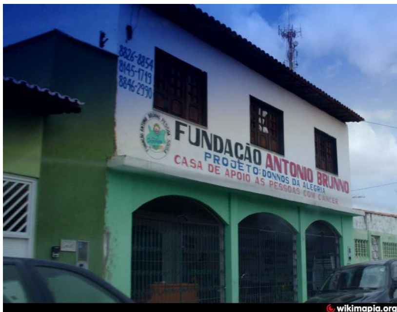
Figura 2 - Registro da primeira Casa de Apoio. Cohatrac I
