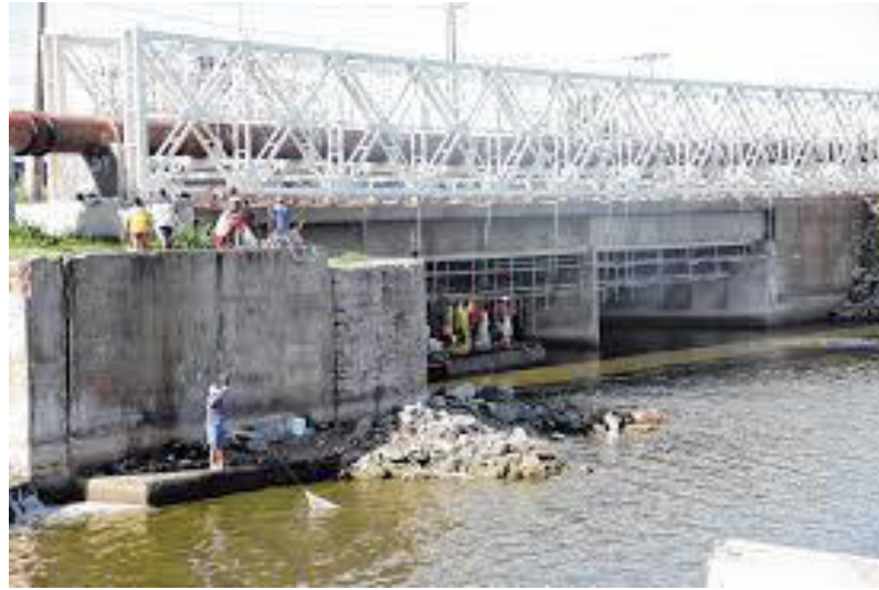
Figura 3. Barragem do Bacanga.
