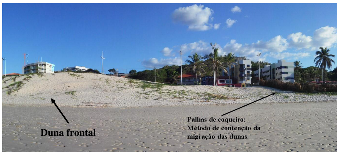
Figura 37. Medida mitigatória para a contenção do transporte eólico com palhas na Praia do Calhau.
