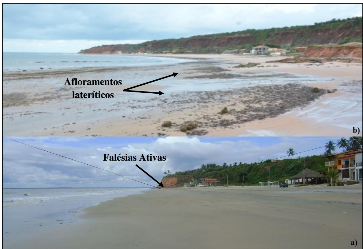
Figura 46. Vista da praia de Panaquatira. Falésias ativas (a) conglomerado de rochas lateríticas na face praial (b) (FONTE: PEREIRA, 2018).
