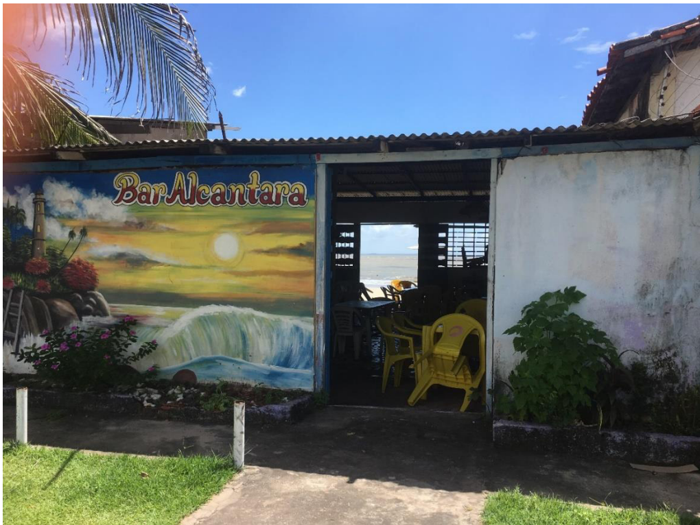
Figura 11: Bar Murado na Praia Fonte: Thaynara Correia
