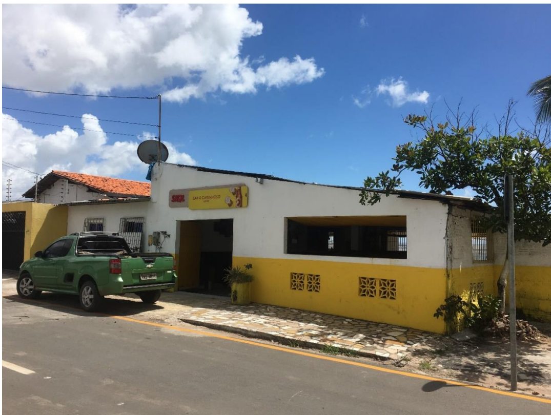
Figura 10: Bar murado na praia Fonte: Thaynara Correia
