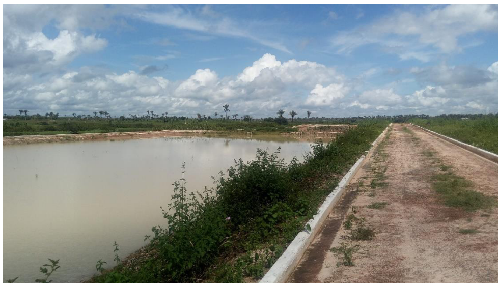
Figura 1 Estação de Tratamento de Esgoto no Bairro Novo Bacabal
