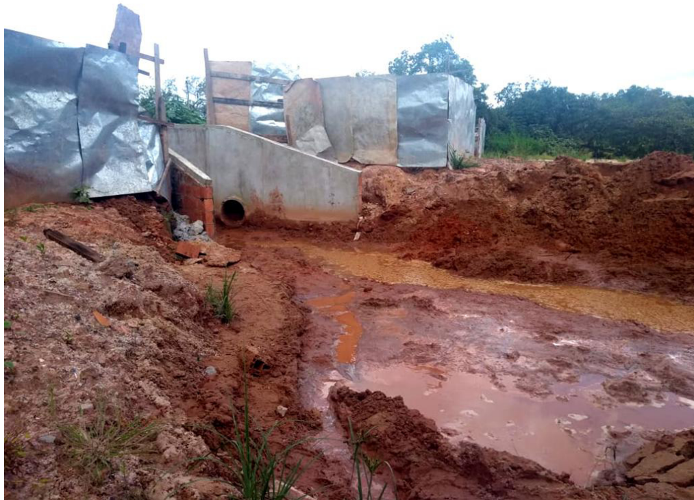
Figura 20 – Dissipador de Energia Fonte: Autora, 2018.
