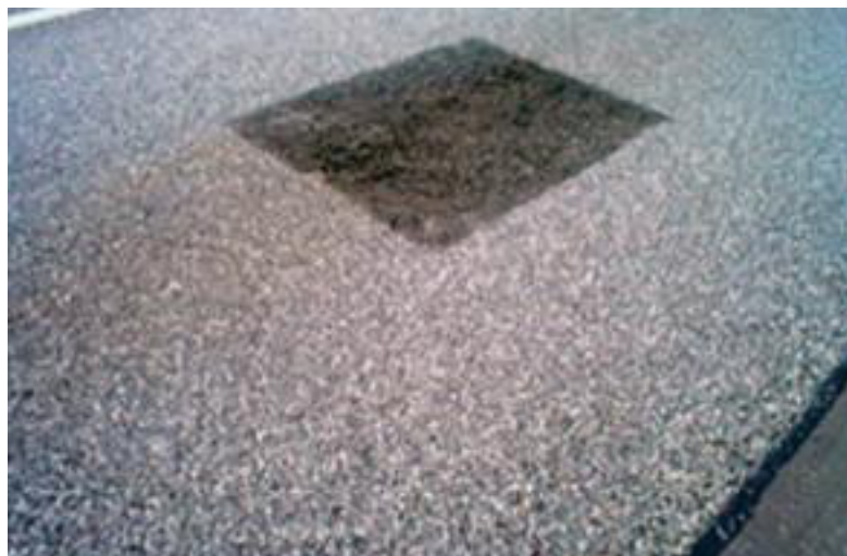
Figura 19 - Remendo profundo
