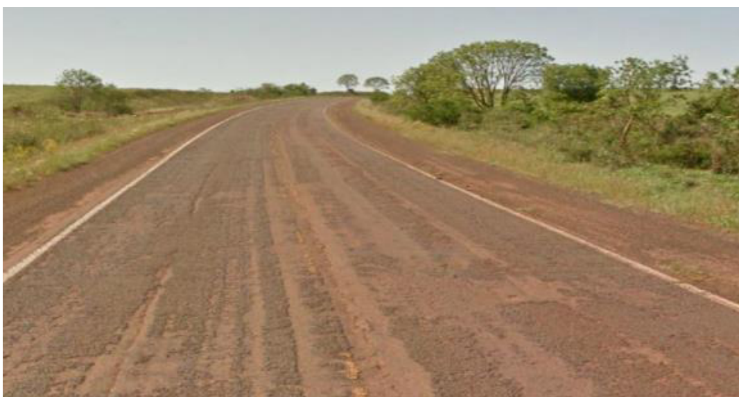
Figura 14 - Desgaste
