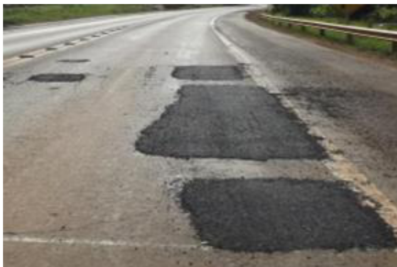
Figura 18 - Remendo superficial
