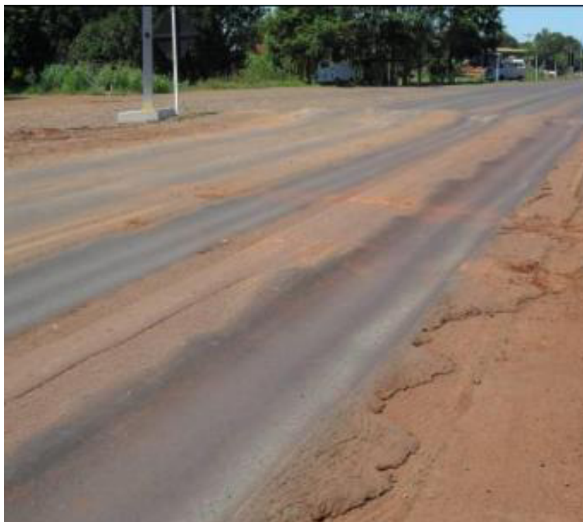
Figura 11 - Afundamento plástico
