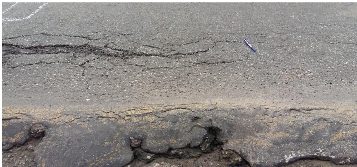
Figura 30 - Escorregamento (estação 114)
