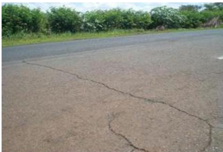
Figura 6 - Trinca transversal
