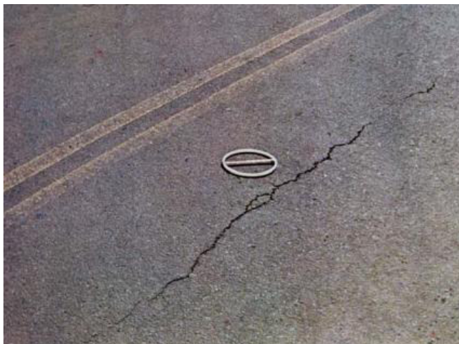
Figura 7 - Trinca longitudinal
