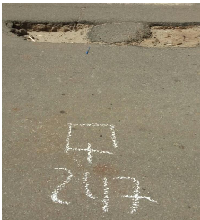
Figura 29 - Panelas (estação 247)
