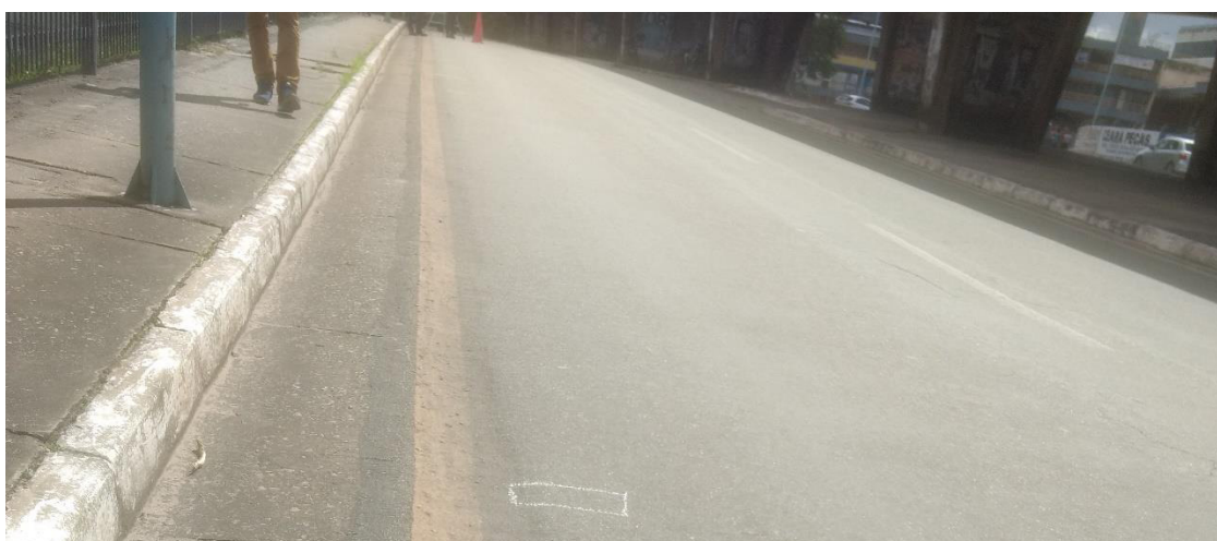
Figura 5 – Pavimento Flexível da Avenida Daniel de La Touche
