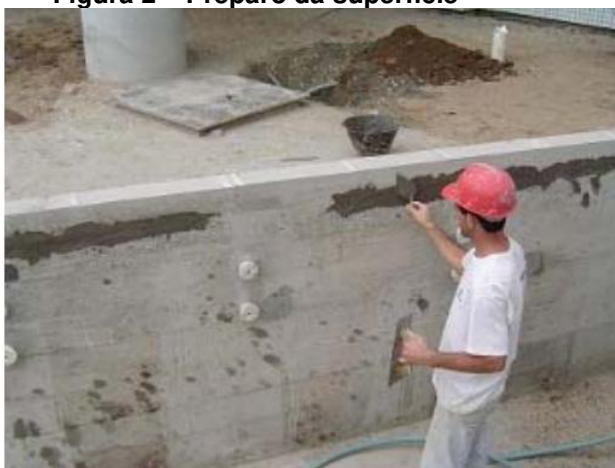
Figura 2 – Preparo da superfície
