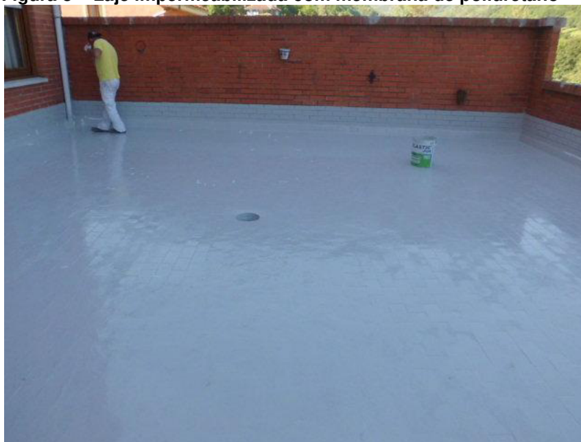
Figura 8 – Laje impermeabilizada com membrana de poliuretano
