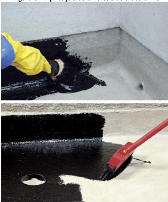
Figura 3 – Aplicação de emulsão asfáltica a frio
