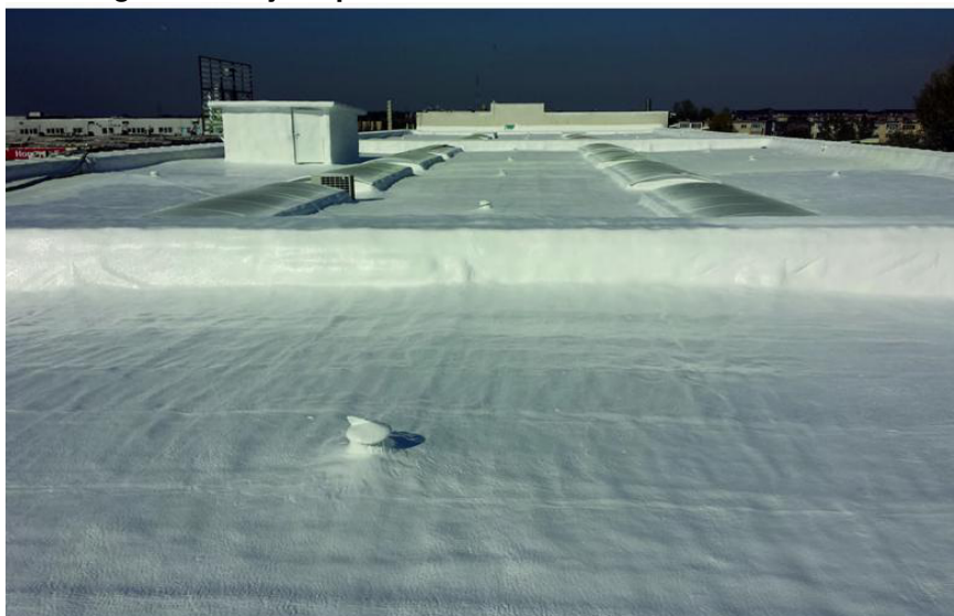
Figura 7 – Laje impermeabilizada com membrana acrílica
