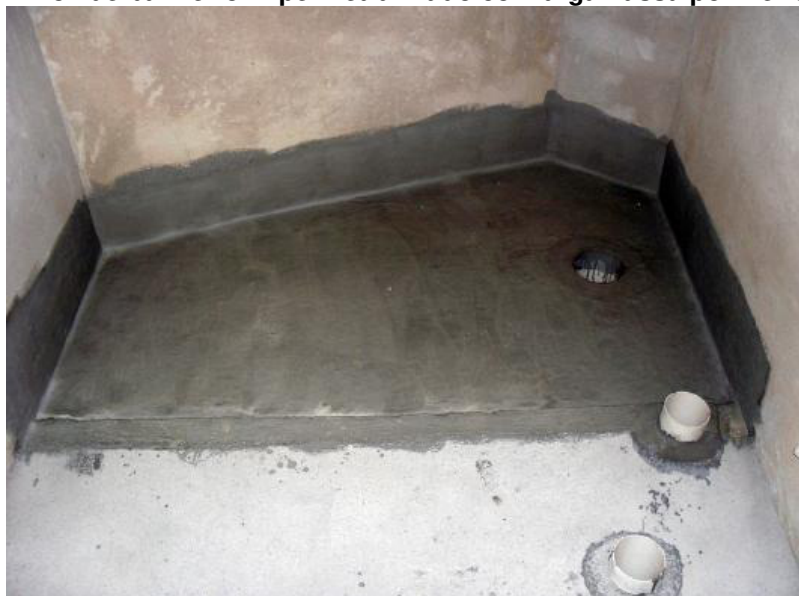
Figura 6 – Box de banheiro impermeabilizado com argamassa polimérica
