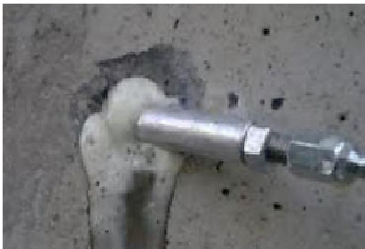
Depois da realização do reparo, consequentemente o carregamento de areia pela captação de água advindas da infiltração foi resolvido, no entanto as tubulações que estavam no piso em contato com a umidade, ficaram bem deterioradas por conta da corrosão. Por isso, tiveram que ser trocadas por novas peças (figura 70), possibilitando um aumento de vida útil.
