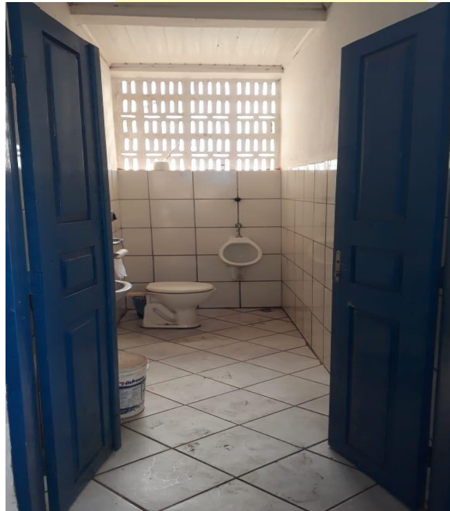
Foto 4 - Entrada do banheiro masculino
