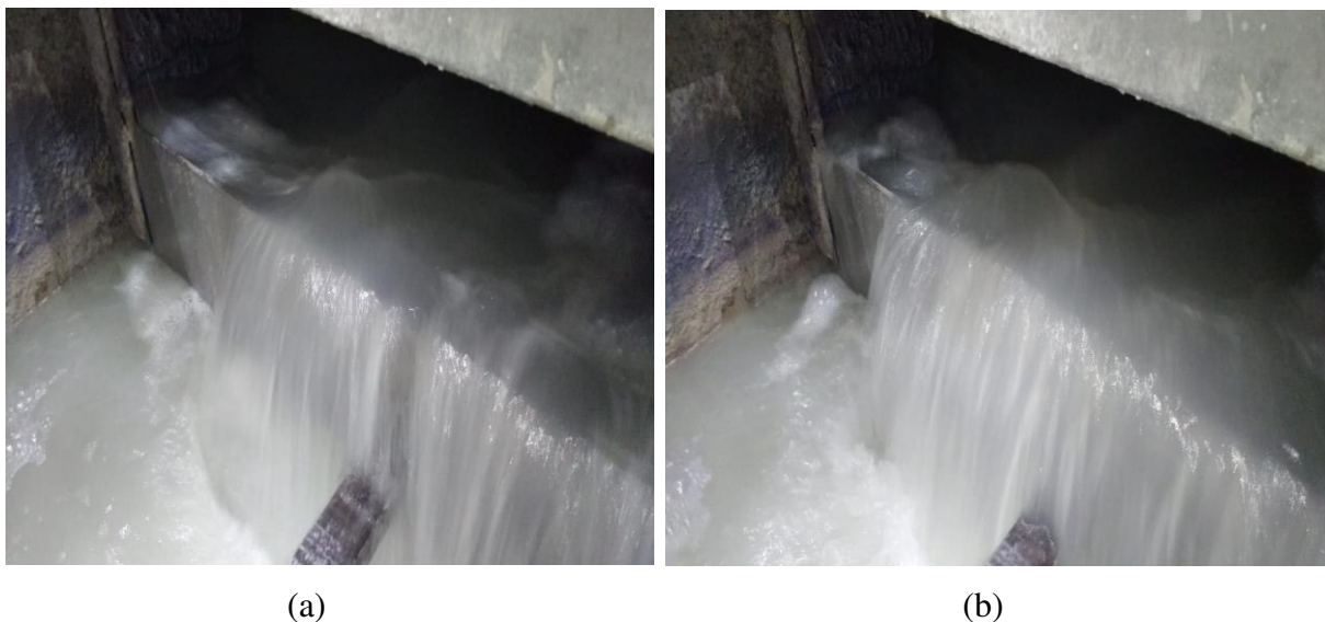
Figura 26 – (a) e (b) Água sem espuma na calha de água branca com dosagem de químicos.
