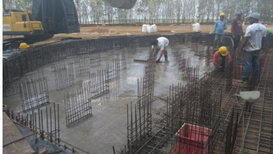
Figura 59 - Concretagem da laje da base
