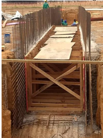
Figura 51 - Fôrmas e escoramento para concretagem das paredes do túnel
