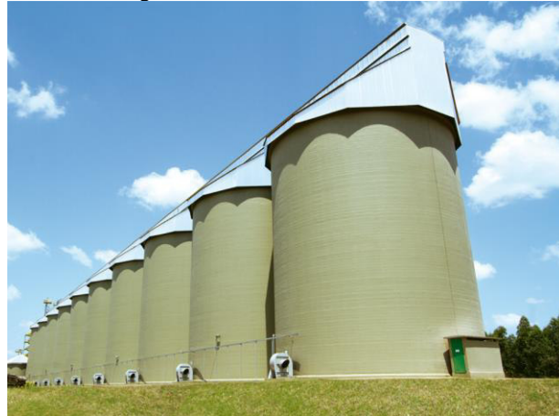
Figura 14 - Silos de concreto
