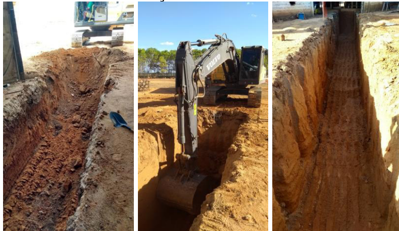
Figura 39 - Processo de escavação do túnel usando a escavadeira hidráulica
