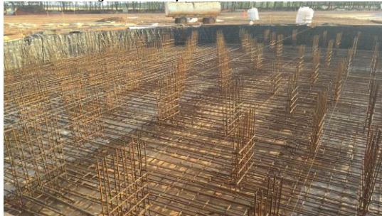
Figura 58- Armação dos pilares dos canais de aeração
