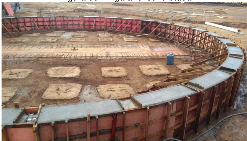
Figura 53 - Viga anel concretada
