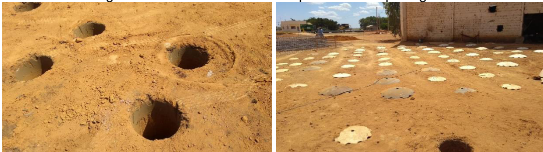
Figura 34 - Furos devidamente perfurados e protegidos
