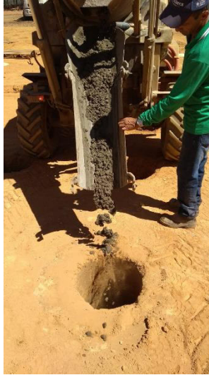
Figura 37 - Concretagem das estacas
