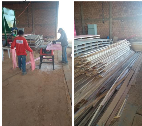
Figura 28 - Madeira utilizada na obra
