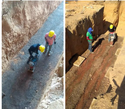
Figura 48 - Compactação do fundo do túnel com compactador mecânico
