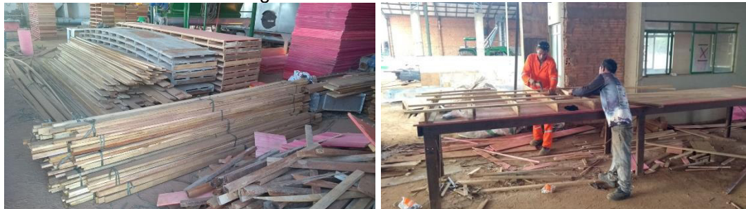
Figura 26 - Central de fôrmas
