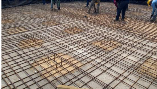
Figura 57 - Armação da laje do piso central
