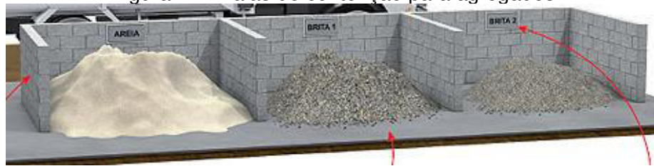
Figura 27 - Baias de contenção para agregados
