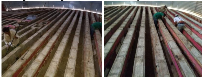
Figura 66 - Vigas dos canais de aeração concretadas
