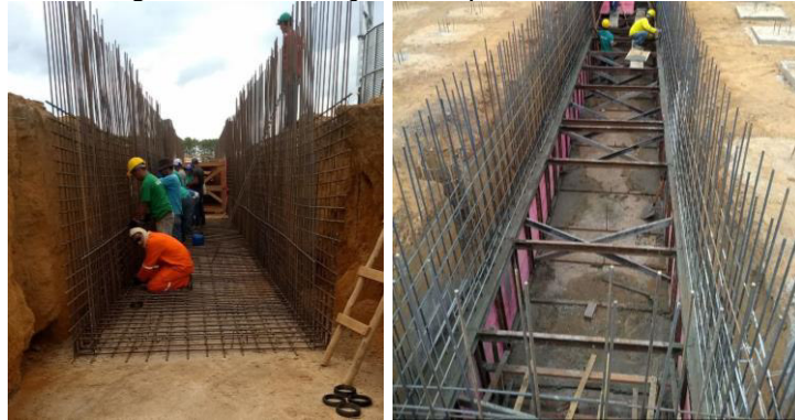
Figura 50 - Armação das paredes do túnel
