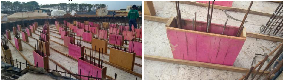
Figura 64 - Fôrmas dos canais de aeração
