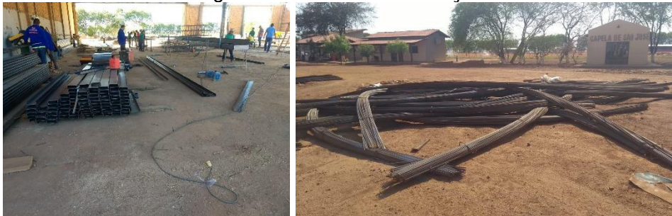
Figura 25 - Central de armação
