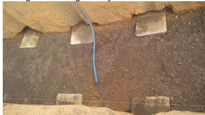
Figura 47 - Regularização do fundo do túnel
