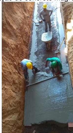
Figura 49 - Aplicação do concreto magro no fundo do túnel
