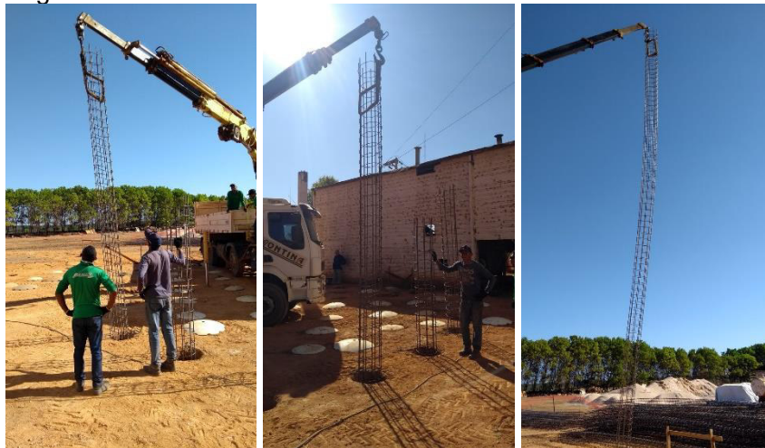
Figura 35 - Posicionamento da armadura nos furos das estacas
