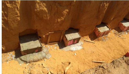
Figura 46 - Blocos de coroamento do túnel concretados
