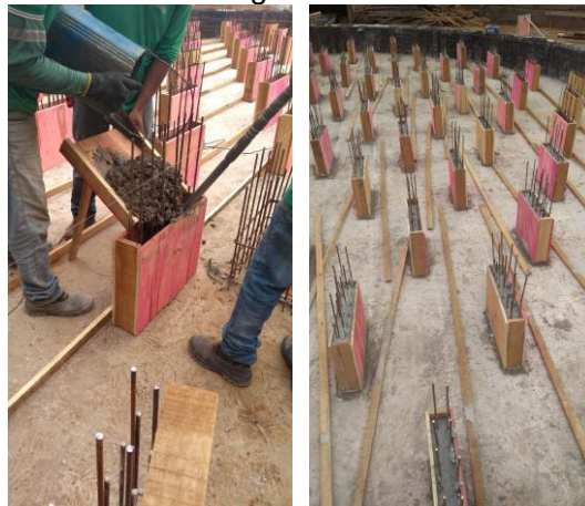
Figura 65 - Concretagem dos canais de aeração
