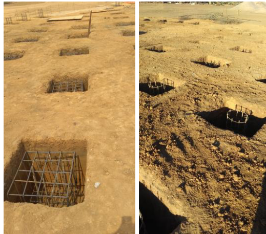
Figura 44 - Blocos de coroamento escavados com a ferragem colocada
