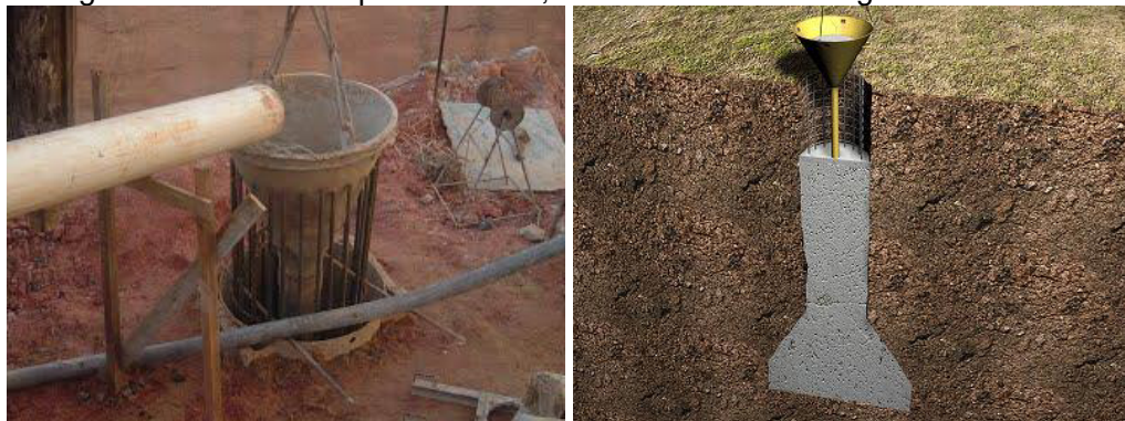
Figura 36 - Funil do tipo tremonha, utilizado na concretagem de estacas
