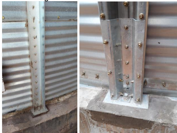
Figura 17 - Montante do silo
