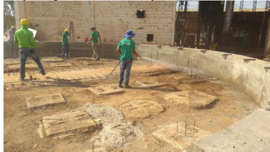
Figura 54 - Preparação do terreno para receber o concreto magro
