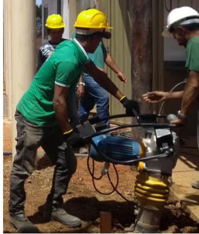
Figura 31 - Processo de compactação utilizando um compactador mecânico
