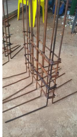
Figura 61 - Armação das canaletas de aeração
