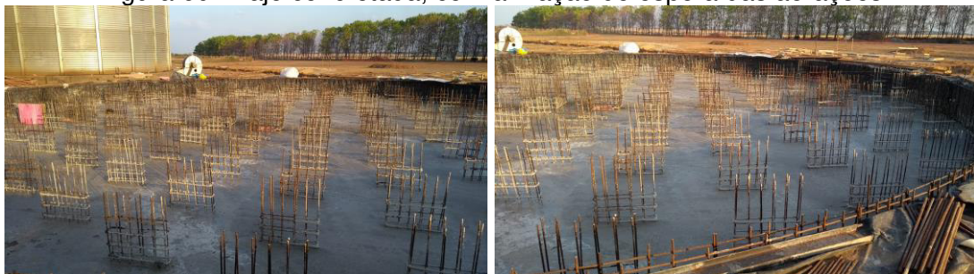
Figura 60 - Laje concretada, com armação de espera das aerações
