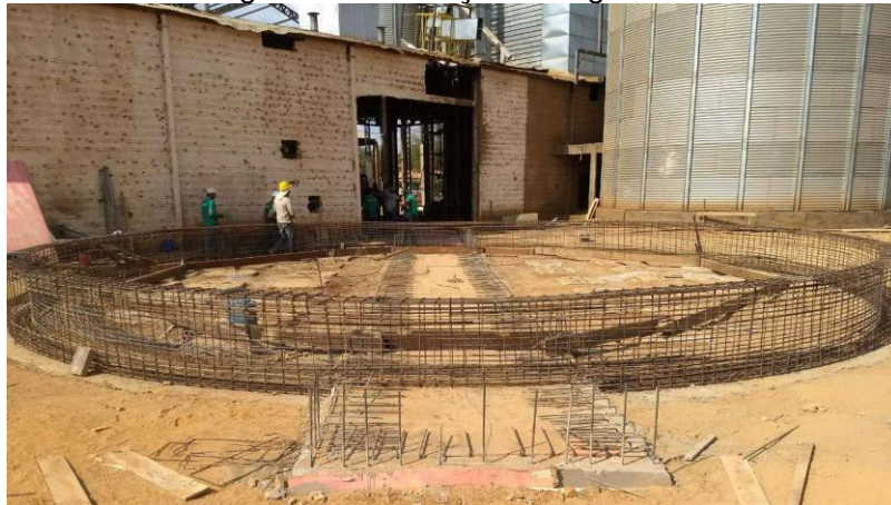
Figura 52 - Armação da viga anel
