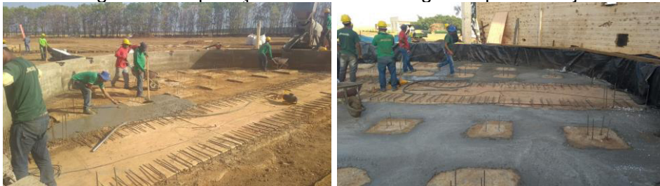
Figura 55 - Aplicação do concreto magro no piso da laje
