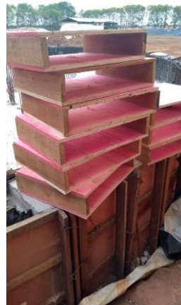
Figura 62 - Fôrmas executadas para canais de aeração
