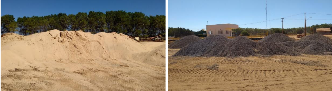
Figura 23 - Local destinado aos agregados miúdos e graúdos da obra
