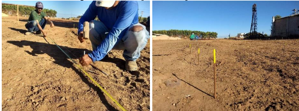
Figura 30 - Execução da locação da obra
