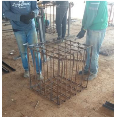
Figura 43 - Armação do bloco de coroamento
