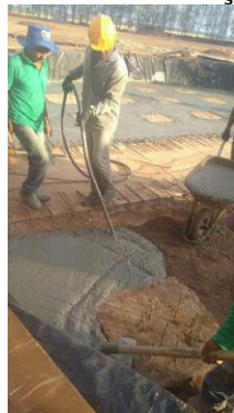
Figura 56 - Processo de vibração do concreto
