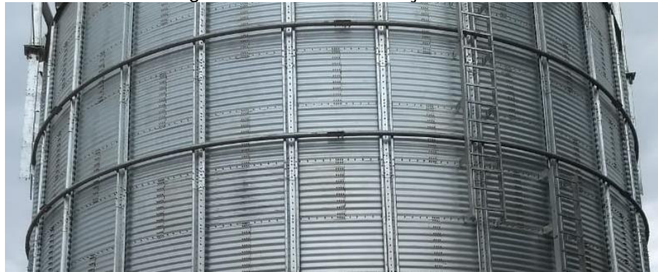
Figura 18 - Anéis de reforço do silo
