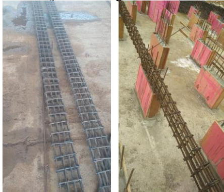
Figura 63 - Armação das vigas dos canais de aeração
