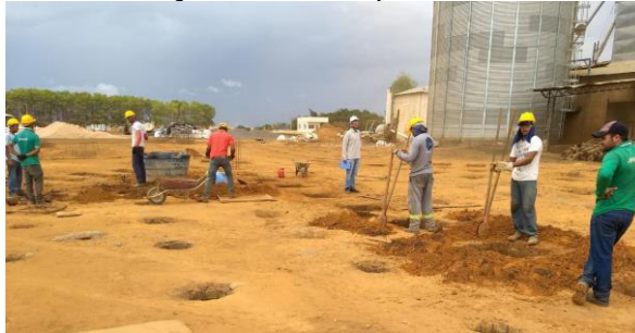
Figura 40 - Escavação das valas para bloco de coroamento
