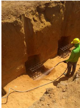
Figura 41 - Preparação do terreno para os blocos de coroamento
