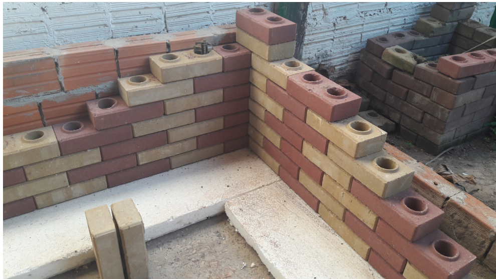
Figura 01 - Tijolo de solo-cimento
