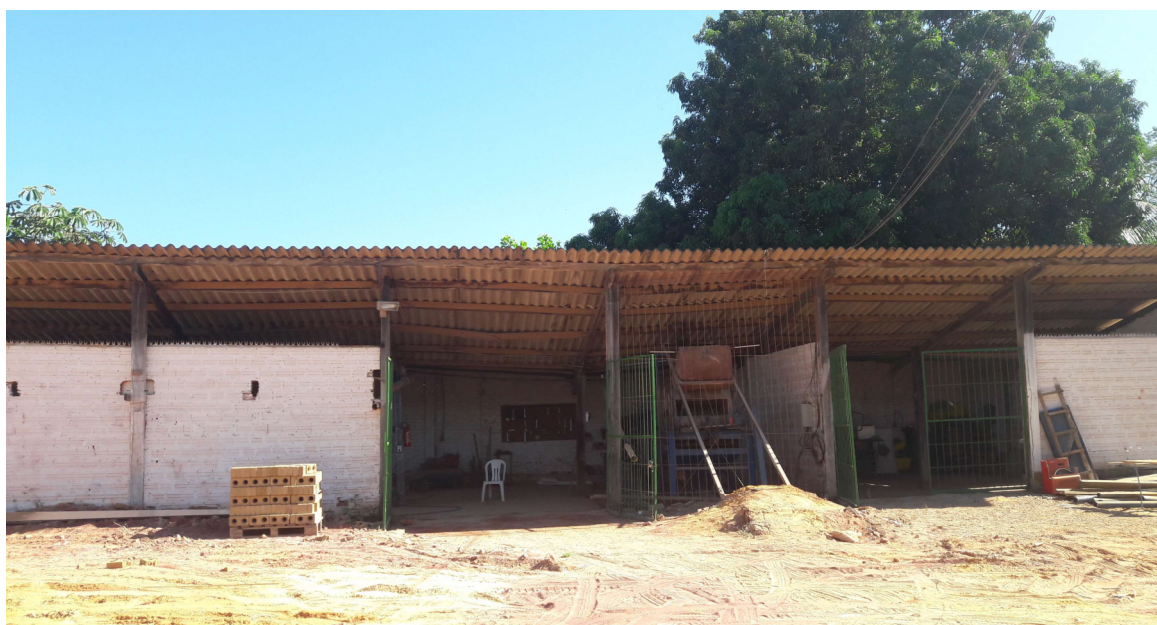
Figura 06 - Fábrica de tijolo de solo-cimento
