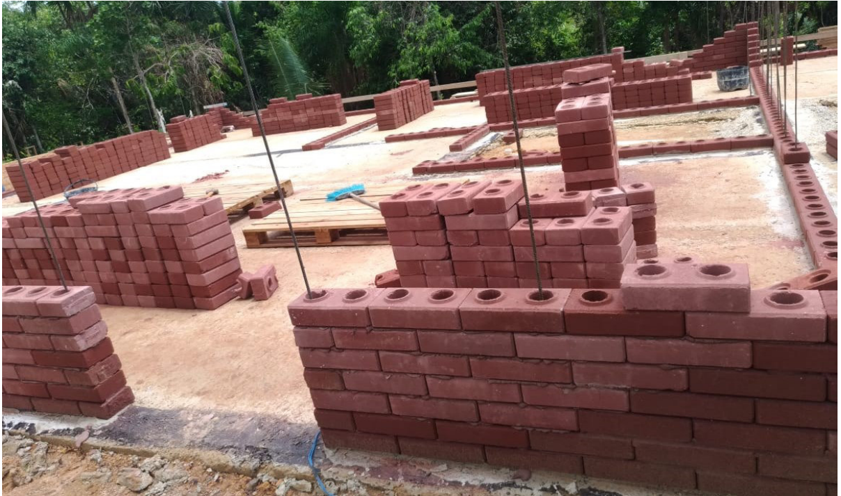
Figura 09 - Assentamento das Alvenarias na fase inicial da construção
