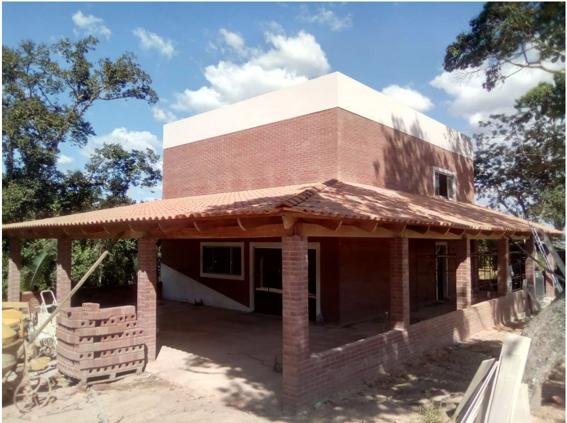
Figura 10 - Fase final da construção da residência de tijolo de solo-cimento
