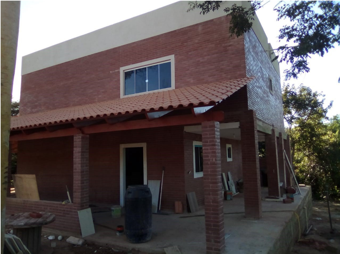
Figura 11 - Fase final da construção da residência de tijolo de solo-cimento
