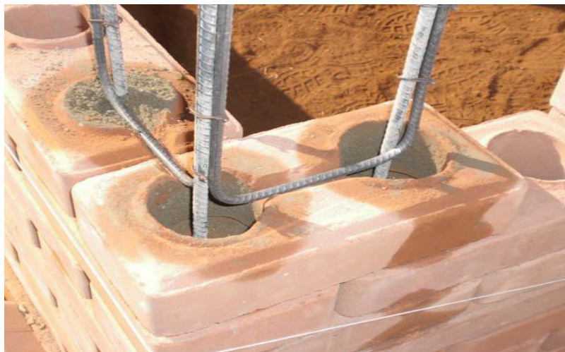
Figura 27 - Encontro de parede com vergalhão “U”
