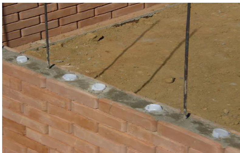
Figura 28 - Uso de copos nas canaletas
