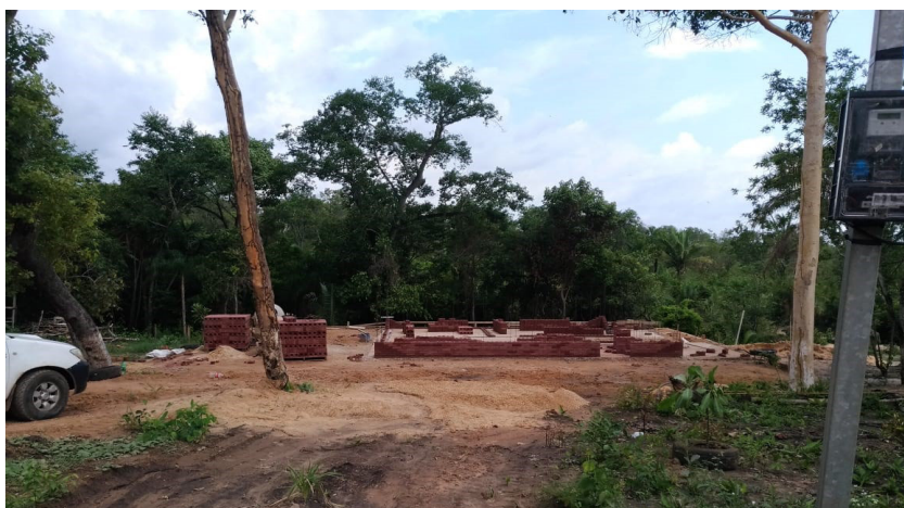
Figura 08 - Fase inicial da construção da residência de tijolo de solo-cimento
