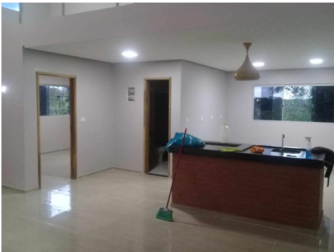
Figura 13 - Interior da residência fase final da construção
