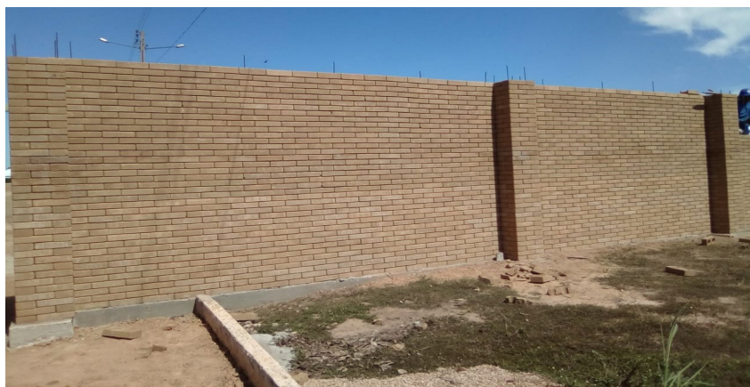
Figura 07 - Muro de tijolo de solo-cimento
