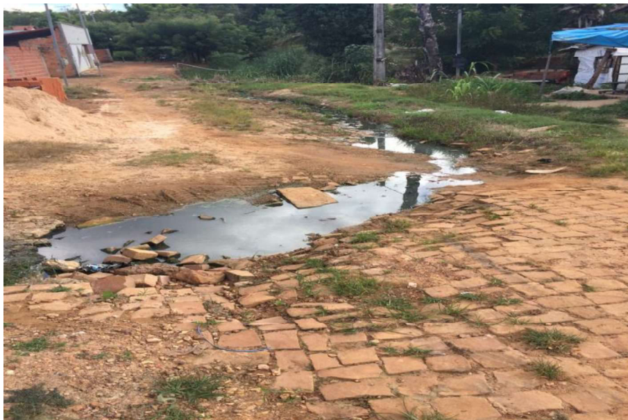
Figura 4 - Lançamento de esgoto diretamente nas ruas
