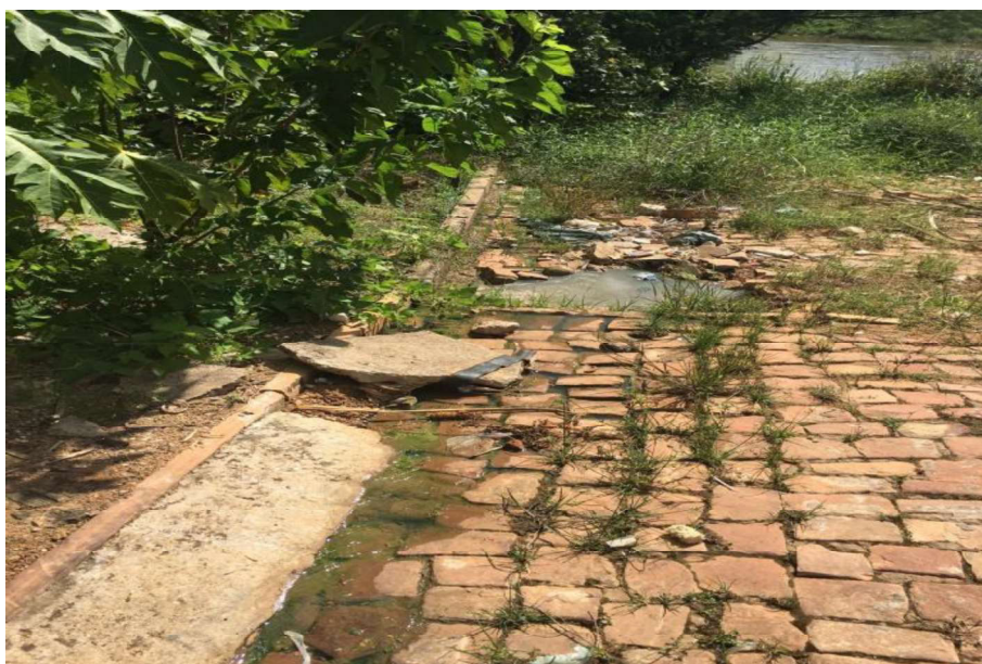
Figura 2 - Escoamento de esgoto das ruas para o Rio Balsas
