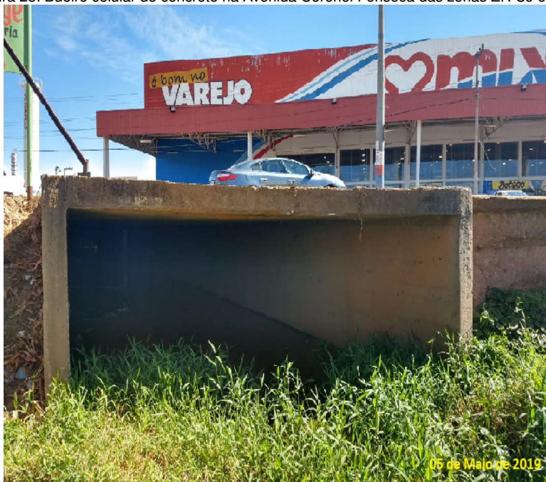
Figura 28: Bueiro celular de concreto na Avenida Coronel Fonseca das zonas ZR CJ e ZLR.
