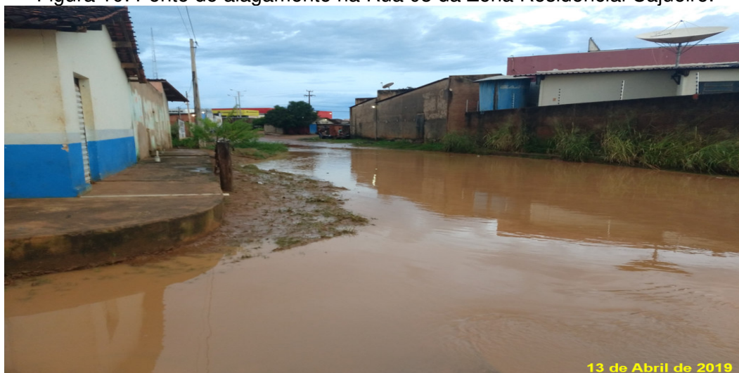
Figura 10: Ponto de alagamento na Rua 03 da Zona Residencial Cajueiro.
