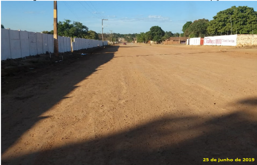
Figura 21: Avenida JK da zona ZRP com revestimento em piçarra
