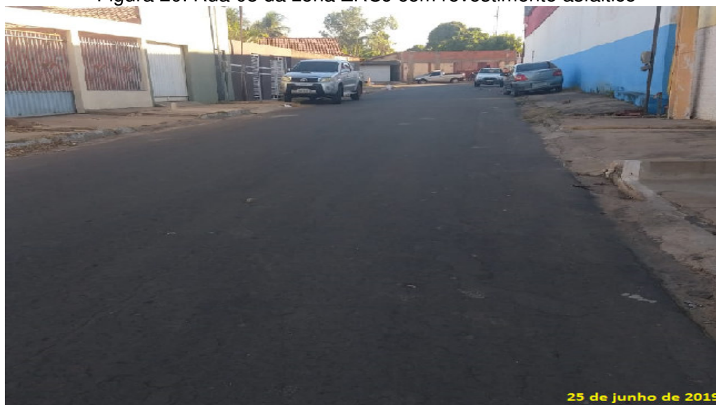
Figura 20: Rua 03 da zona ZRCJ com revestimento asfáltico
