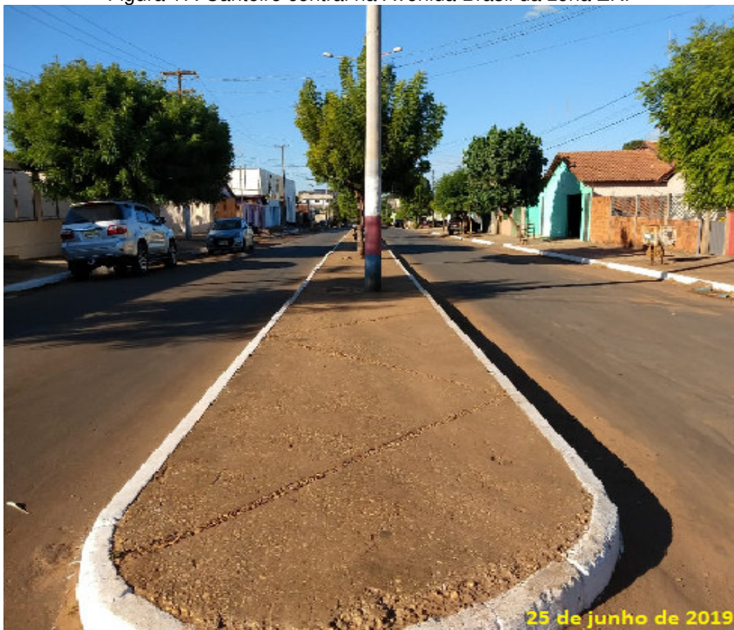
Figura 17: Canteiro central na Avenida Brasil da zona ZRP
