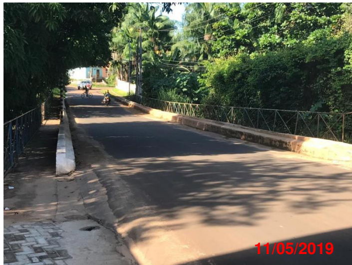
Figura 48 - Ponte 4, sobre o riacho Lava Cara.
