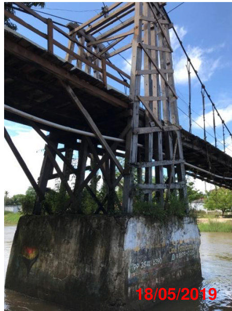
Figura 70 - Estrutura de sustentação da Ponte 06.
