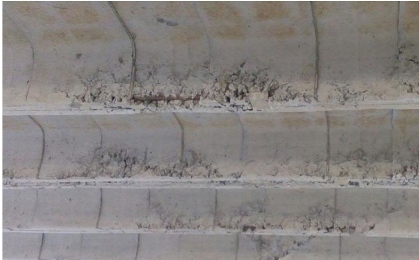
Figura 21 - Ninhos de concretagem.
