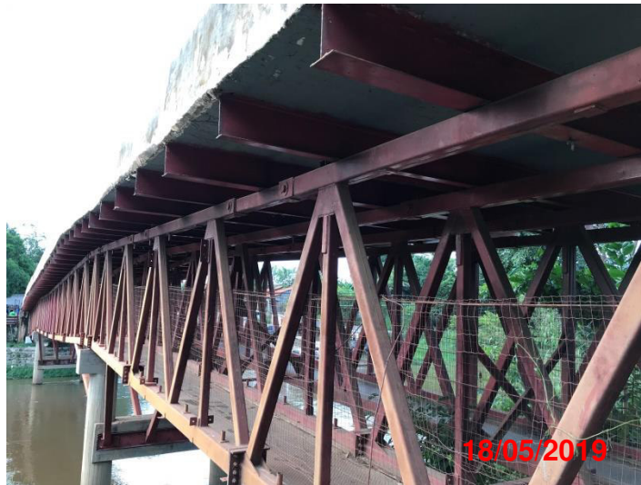
Figura 80 - Perfis metálicos que integram a superestrutura da Ponte 07.
