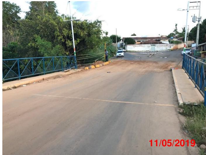
Figura 35 - Vista frontal da Ponte 02.
