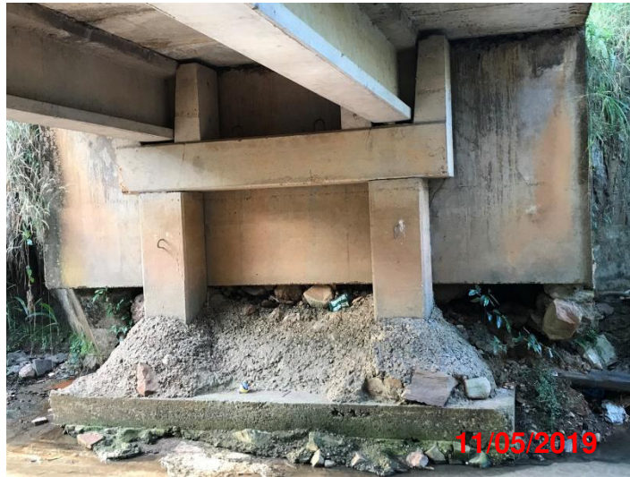
Figura 29 - Elementos estruturais da ponte 01.
