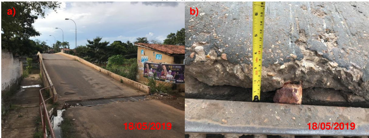
Figura 82 - a) Vala de drenagem superficial. b) Detalhe de diferença de nível entre a grade e a pista de rolamento.
