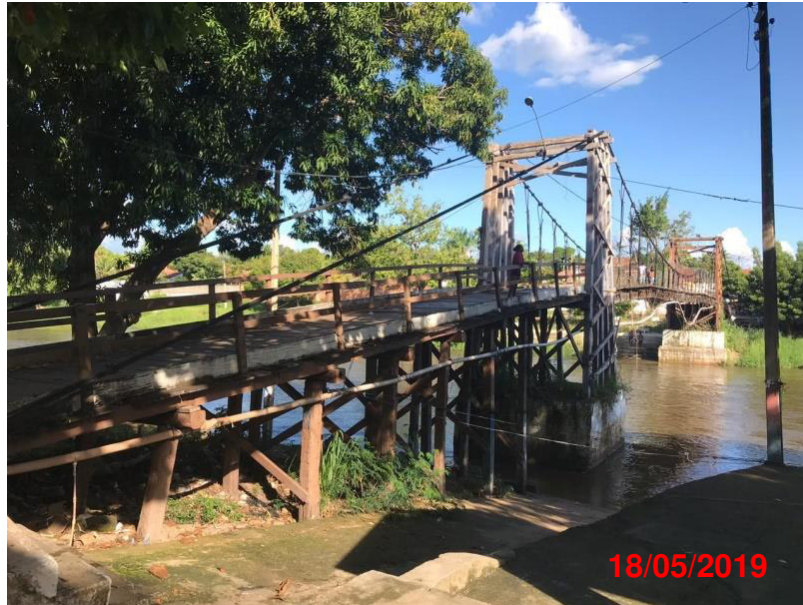
Figura 69 - Ponte Pênsil de Madeira sobre o Rio Balsas.
