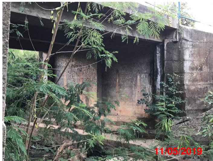
Figura 36 - Vista dos elementos estruturais da Ponte 02.
