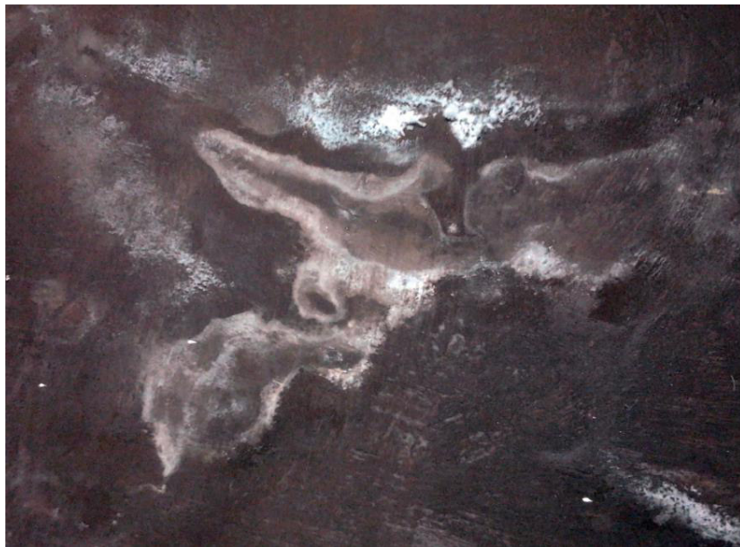
Figura 17 - Depósito de sais em eflorescência.
