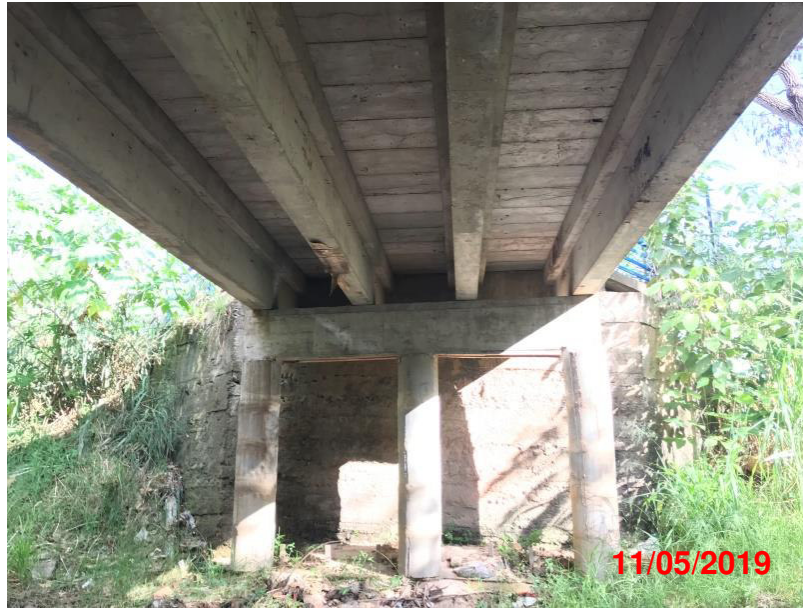
Figura 43 - Sistema estrutural da Ponte 03.
