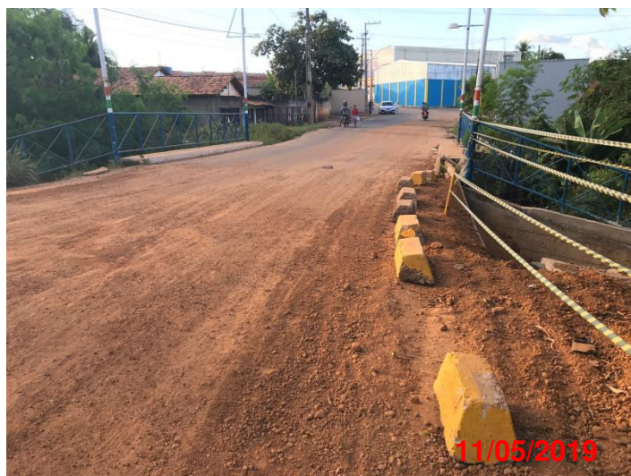
Figura 40 - Obra de nivelamento do piso recalcado.
