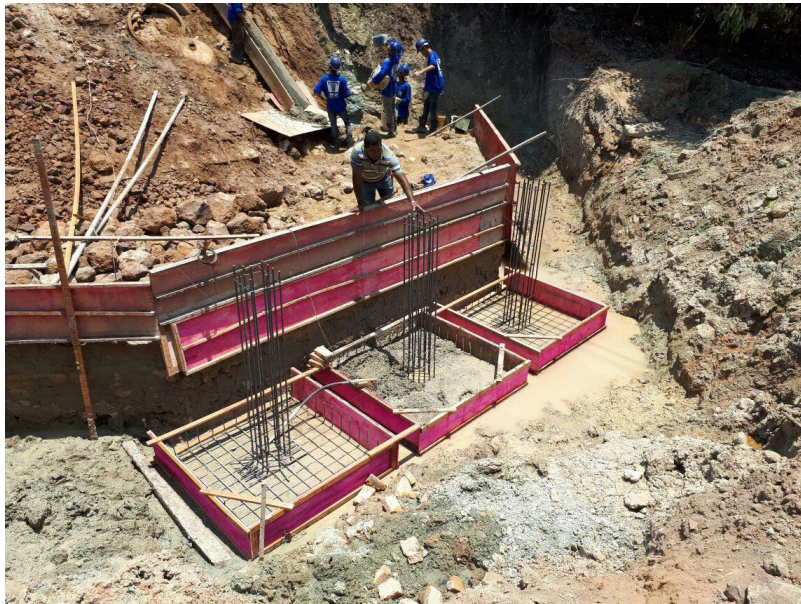
Figura 42 - Construção de sapatas da Ponte 03.
