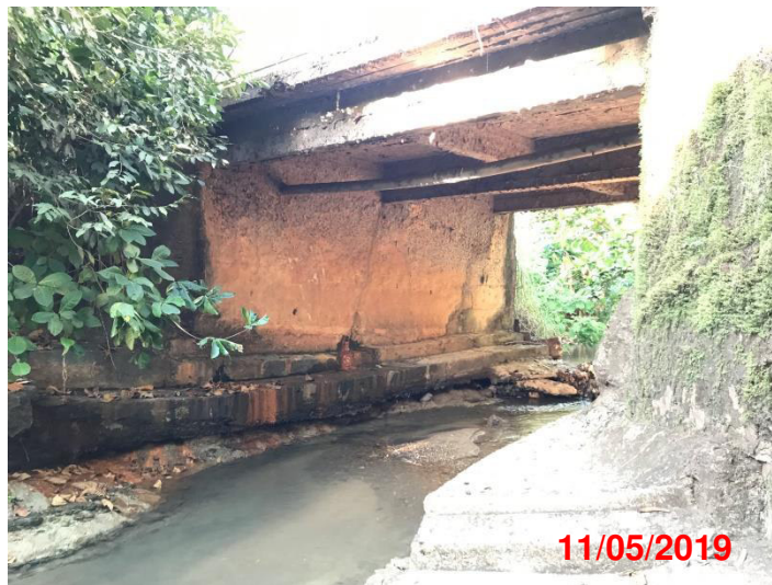
Figura 49 - Mesoestrutura da Ponte 04.
