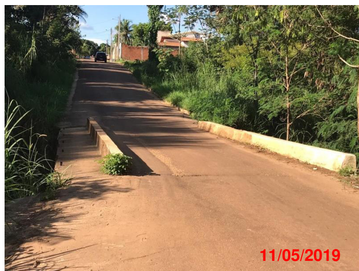
Figura 28 - Ponte 01, localizada na Rua Isaac Martins.
