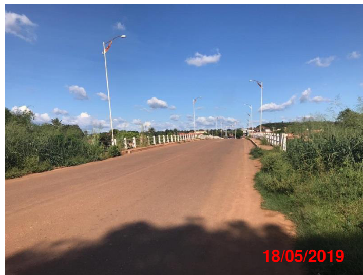
Figura 57 - Ponte de cimento sobre o Rio Balsas - Vista Frontal.
