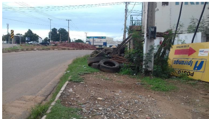
Figura 34- Lixo e obstáculos dispostos nos locais de passagem dos pedestres
