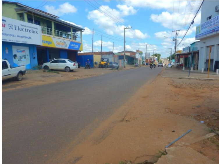
Figura 76- Situação da pavimentação geral do Trecho 02
