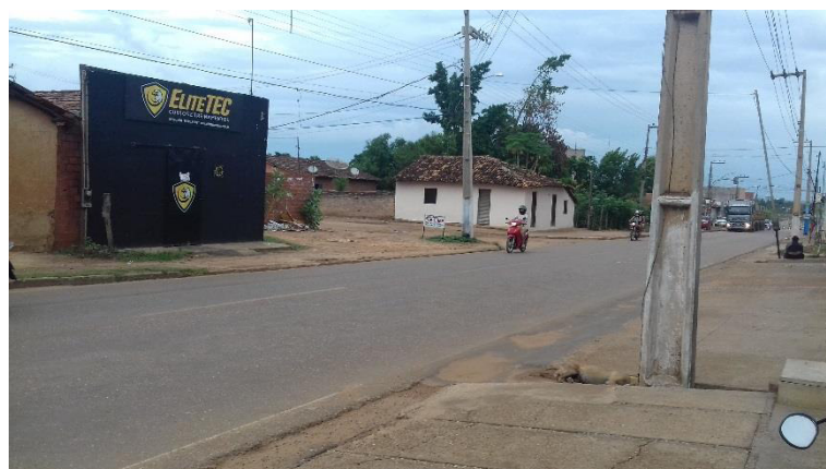
Figura 45- Condição geral do pavimento no Trecho 01
