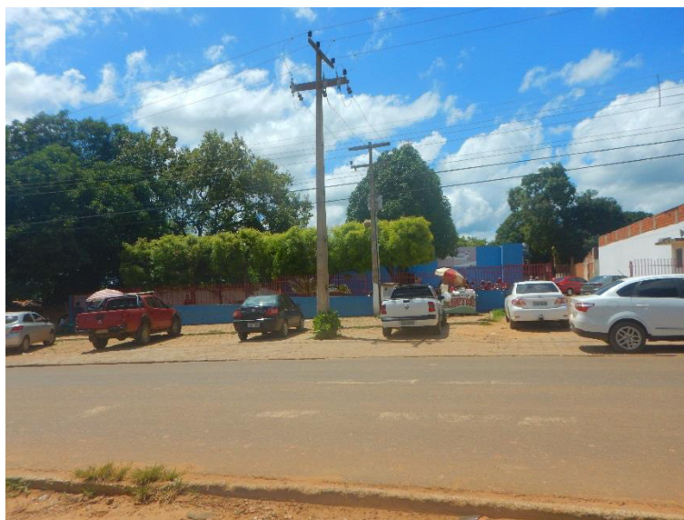
Figura 106-Sinalização horizontal (faixa de pedestres) apagada
