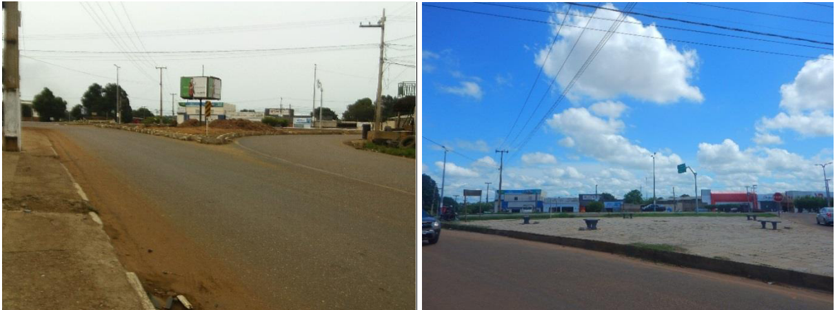
Figura 51- Ilha central- reforma pavimentação
