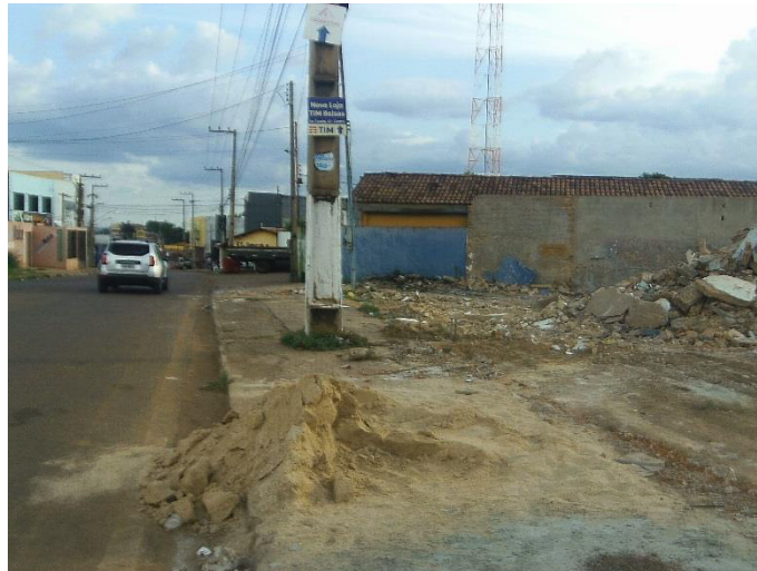
Figura 35- Entulho e materiais de construção dispostos na calçada
