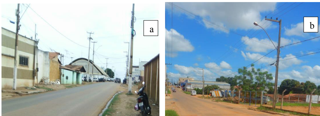
Figura 48- Ausência de placas para orientar o motorista sobre o fluxo permitido
