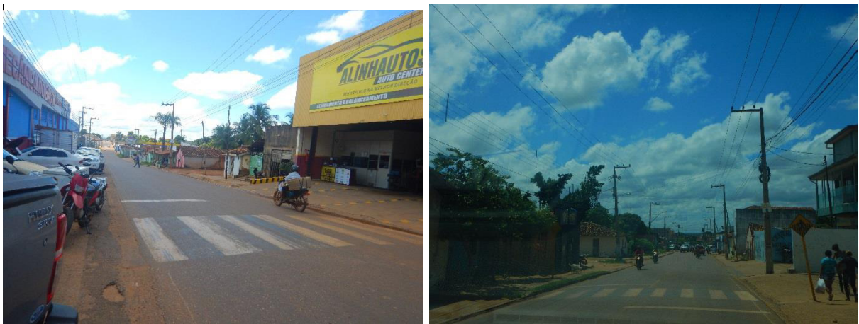
Figura 50-Faixas de pedestres existentes no Trecho 01
