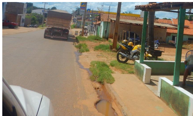
Figura 43- Calçada com largura inadequada
