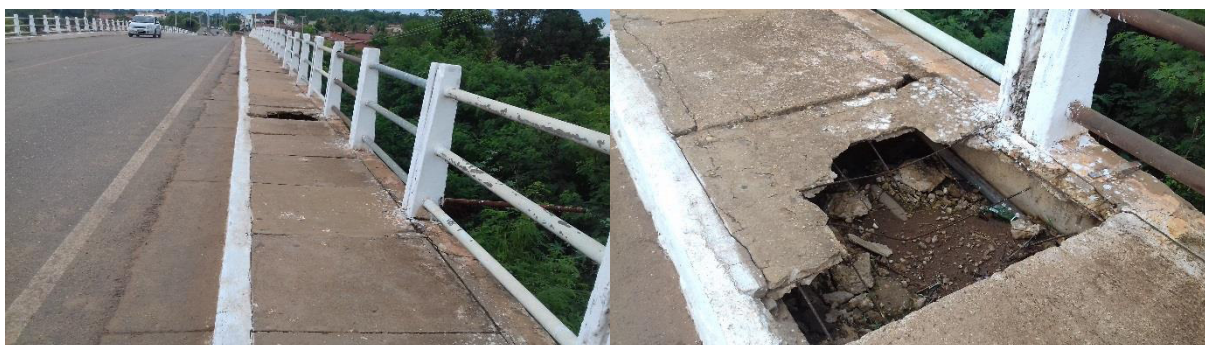
Figura 102- Situação do passeio para pedestres na ponte sobre o Rio Balsas
