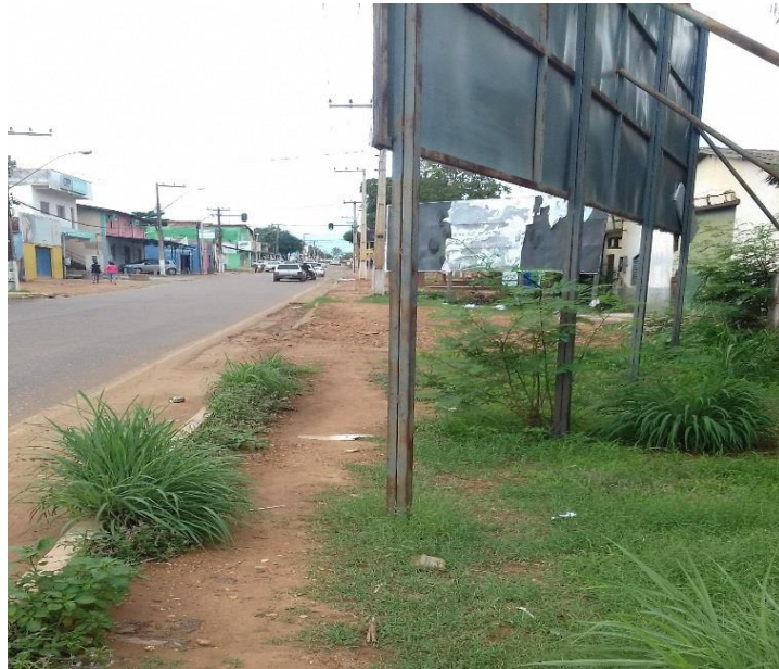
Figura 72- Calçada inexistente-trecho com obstáculos aos pedestres (vegetação e propaganda em outdoor)
