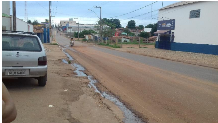
Figura 40-Ausência de guia (meio-fio) facilita o estacionamento de veículos na calçada
