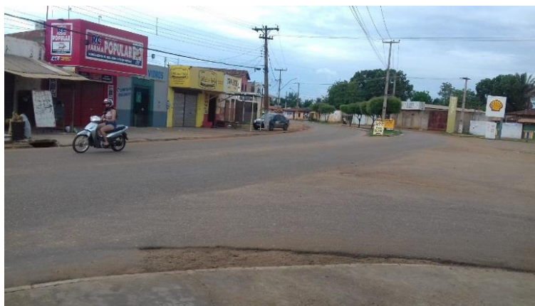
Figura 104- Interseção sem sinalização viária
