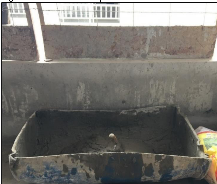
Figura 19 - Maseira exposta ao vento
