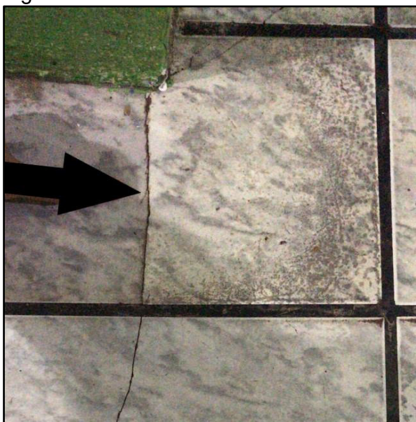
Figura 7 – Trincas
