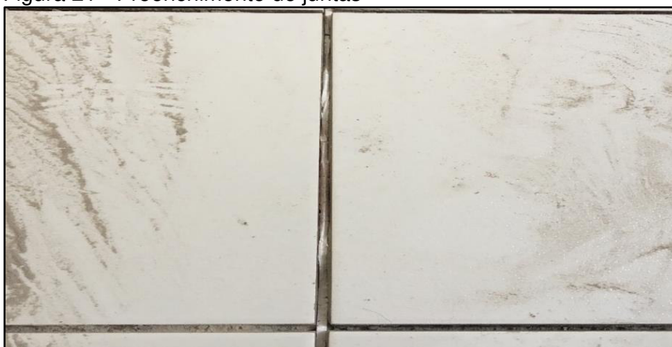
Figura 21 - Preenchimento de juntas
