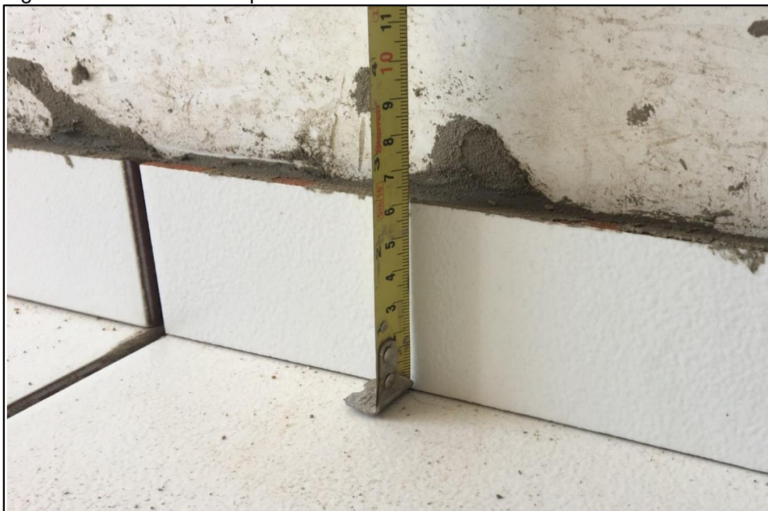
Figura 14: Altura do rodapé cerâmico com 60 mm
