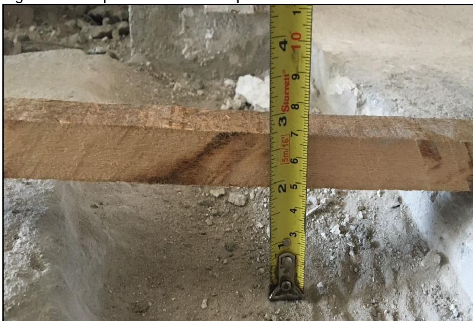
Figura 23 - Espessura do Contrapiso
