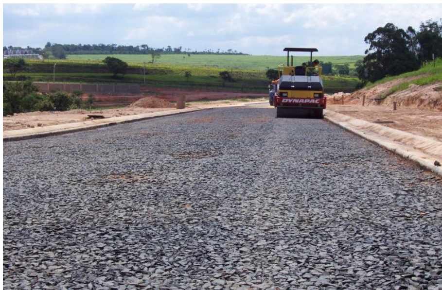
Figura 18 Pavimento sendo construído com RCD.
