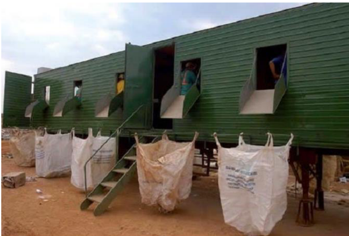
Figura 14 Gestão de resíduos da construção civil.
