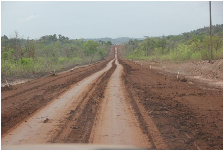
Figura 1 Preparação de terreno para pavimentação urbana na MA-123.
