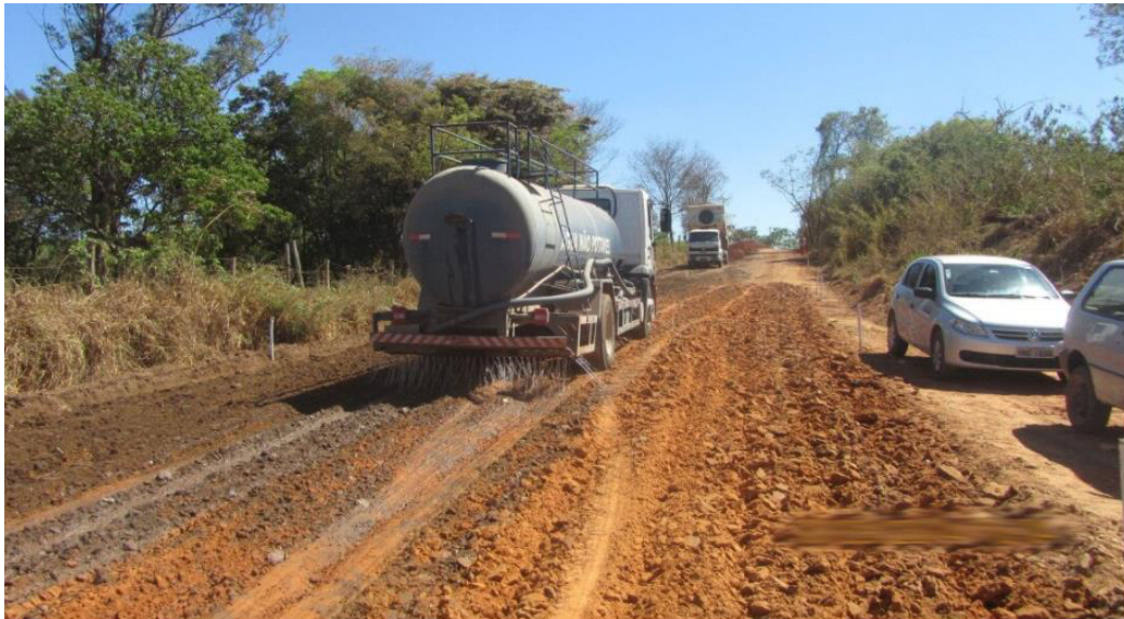
Figura 5 Processo de tratamento e reforço do subleito.
