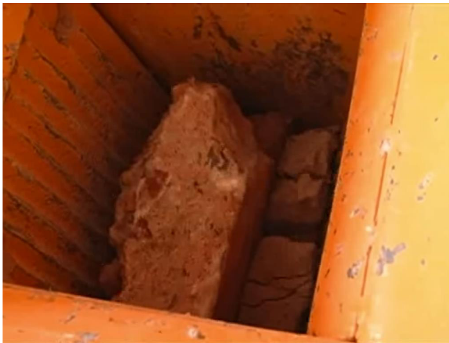
Figura 16 Blocos de concreto sendo triturados.
