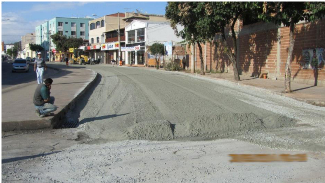
Figura 6 Lançamento de Bica Corrida para base.
