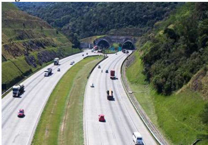
Figura 12 - Rodoanel Mário Covas – Trecho Oeste
