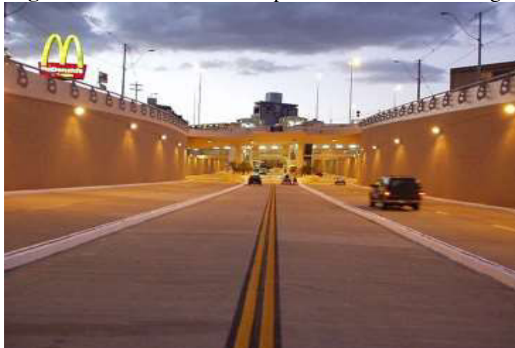
Figura 14 - Avenida terceira perimetral em Porto Alegre
