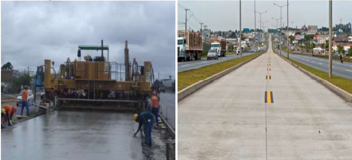
Figura 13 - Linha verde Sul nos corredores de ônibus em Curitiba - PR
