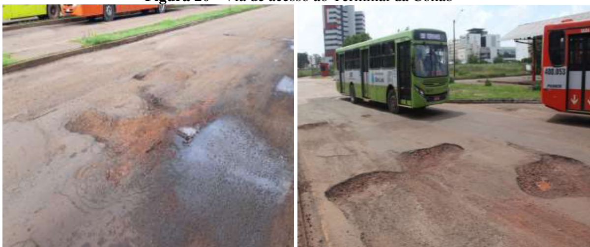
Figura 20 - Via de acesso ao Terminal da Cohab
