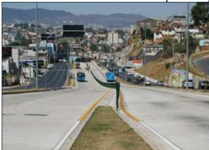
Figura 15 - Avenida Antônio Carlos em BH com pavimentação rígida
