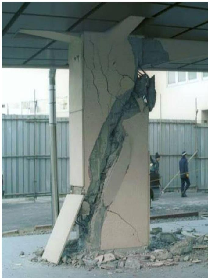
Figura 07: Falha de um pilar devido ao esforço cortante.
