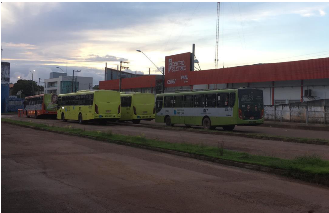
Figura 4 – Terminal de Integração
