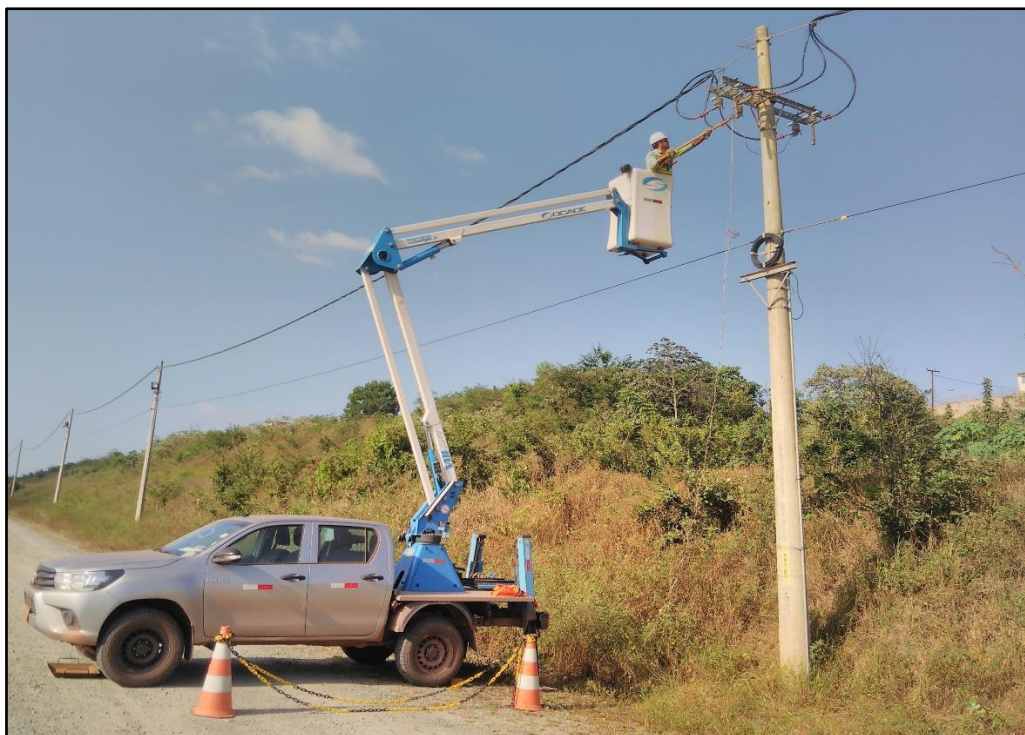
Figura 22: Rede de Distribuição Isolada - RDI
