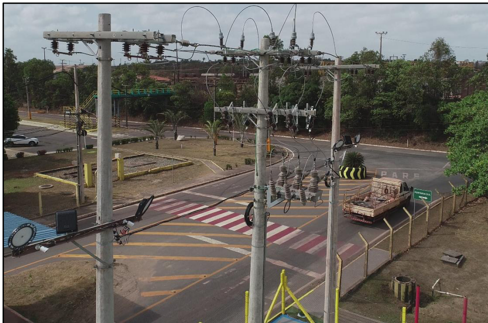
Figura 28: Setor do Religador Automático
