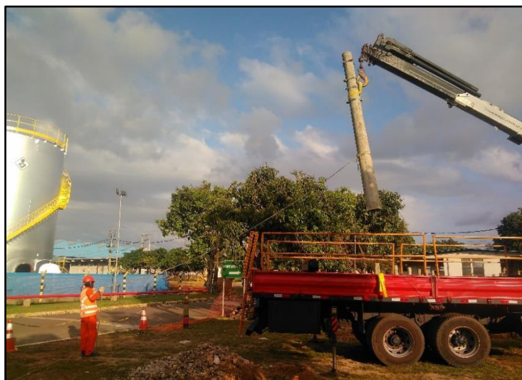
Figura 10: Elevação de poste com caminhão Munk
