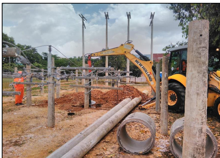
Figura 12: Estruturas montadas e escavação do solo
