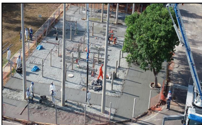
Figura 17: Colaboradores realizando concretagem
