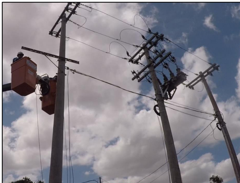
Figura 15: Equipe instalando Religador Automático
