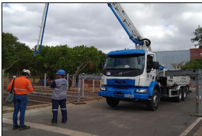
Figura 16: Caminhão Bomba Lança de concreto
