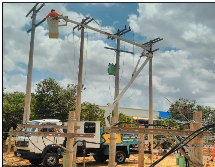
Figura 14: Lançamento dos cabos em rede de simulação
