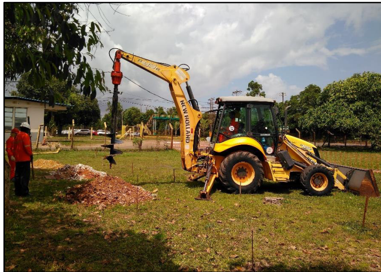
Figura 9: Escavadeira/perfuratriz em atividade de escavação do solo
