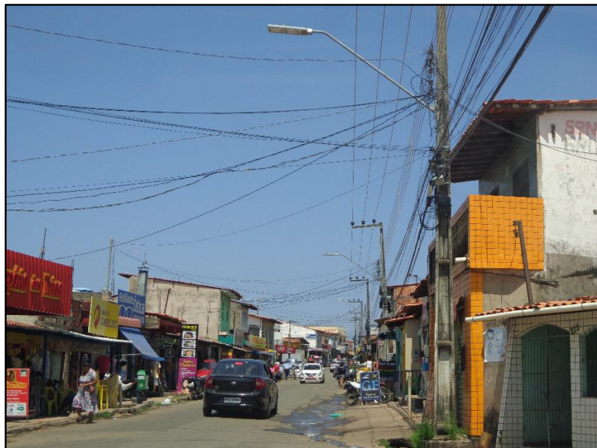
Figura A.4 – Luminária Pública BRP394 A LED174/NW 129W no trecho BC. Fonte Própria.
