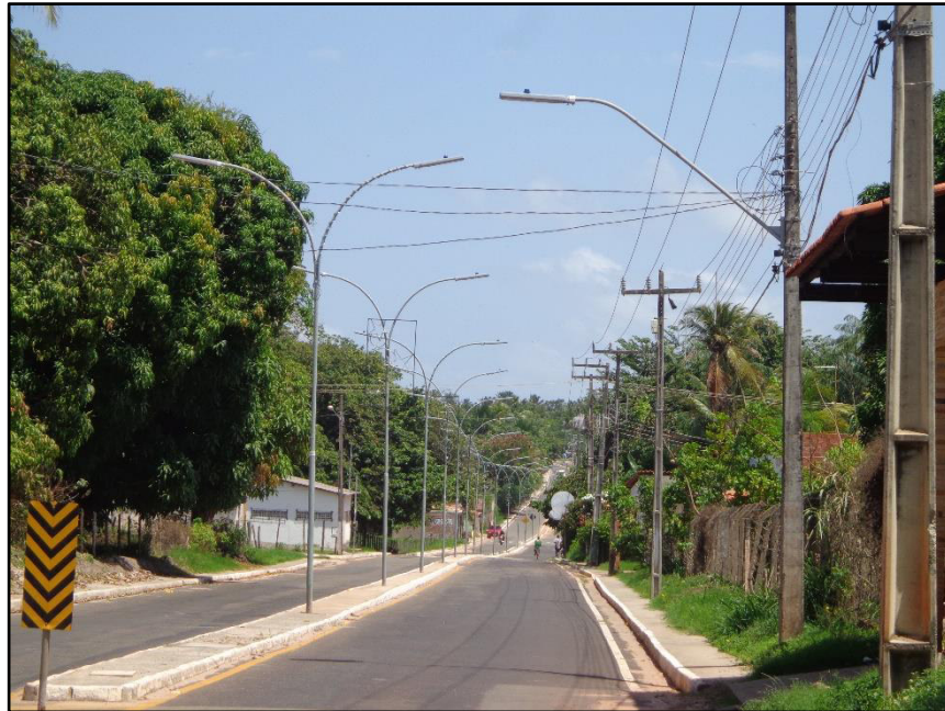
Figura A.5 – Luminária Pública BRP394 129W no trecho CD (duplicado). Fonte Própria.
