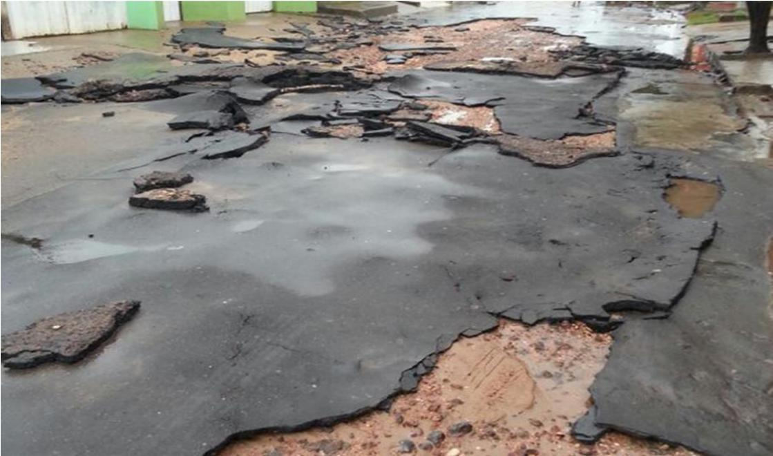
**Figura 17-** Resultado dos estragos causado na rede de asfalto pela enchente de 2014
