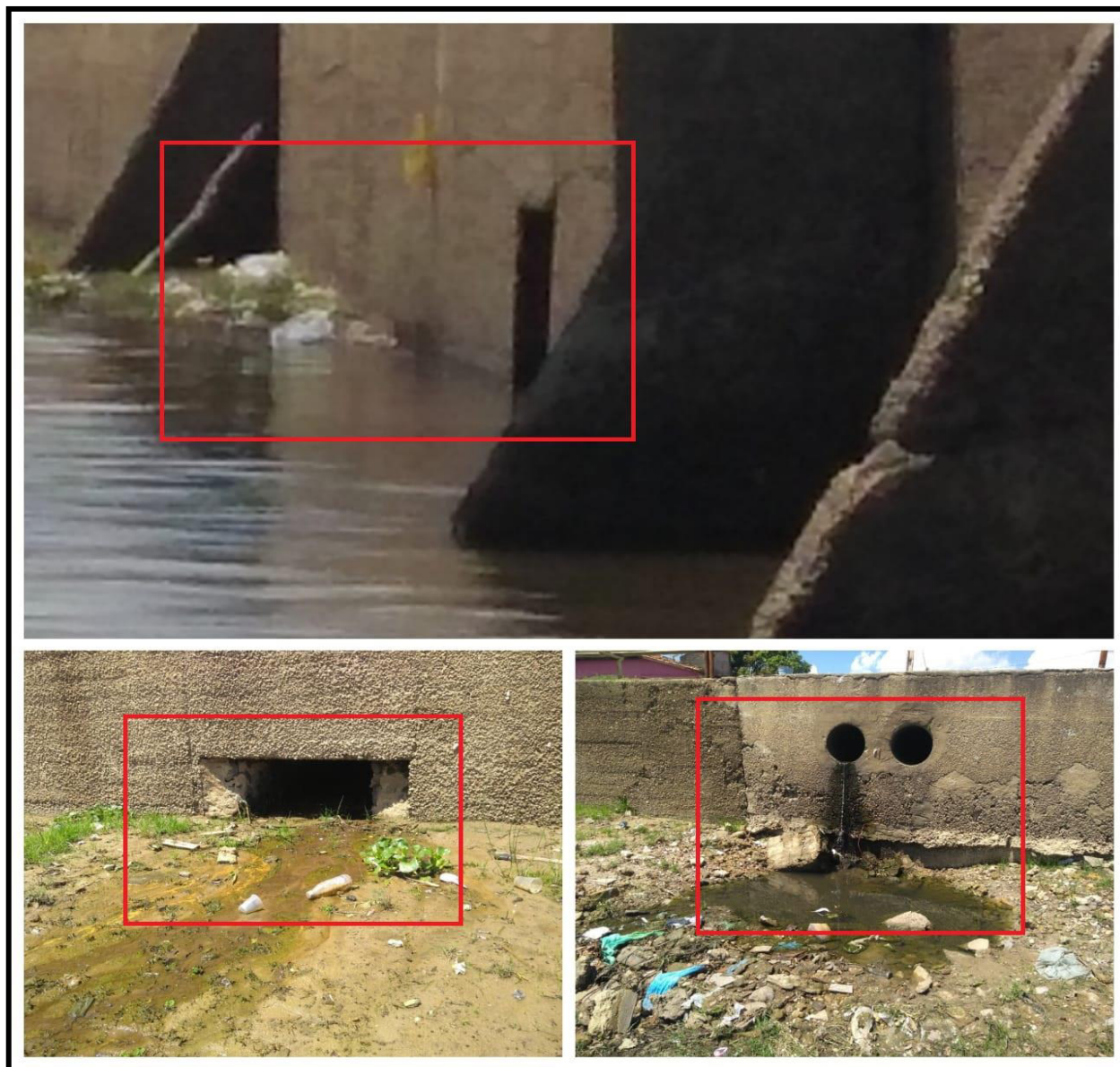
Figura 7 - Pontos específicos em que há galerias de esgoto.
