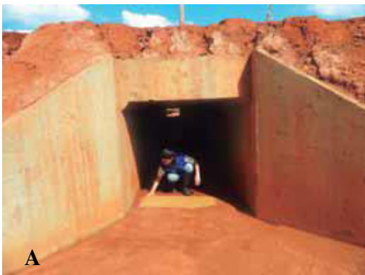
Figura 9 – Exemplos de passagem para fauna, A) passagem tipo caixa; B) Passagem de fauna subterrânea mista na rodovia BR-392/RS.
