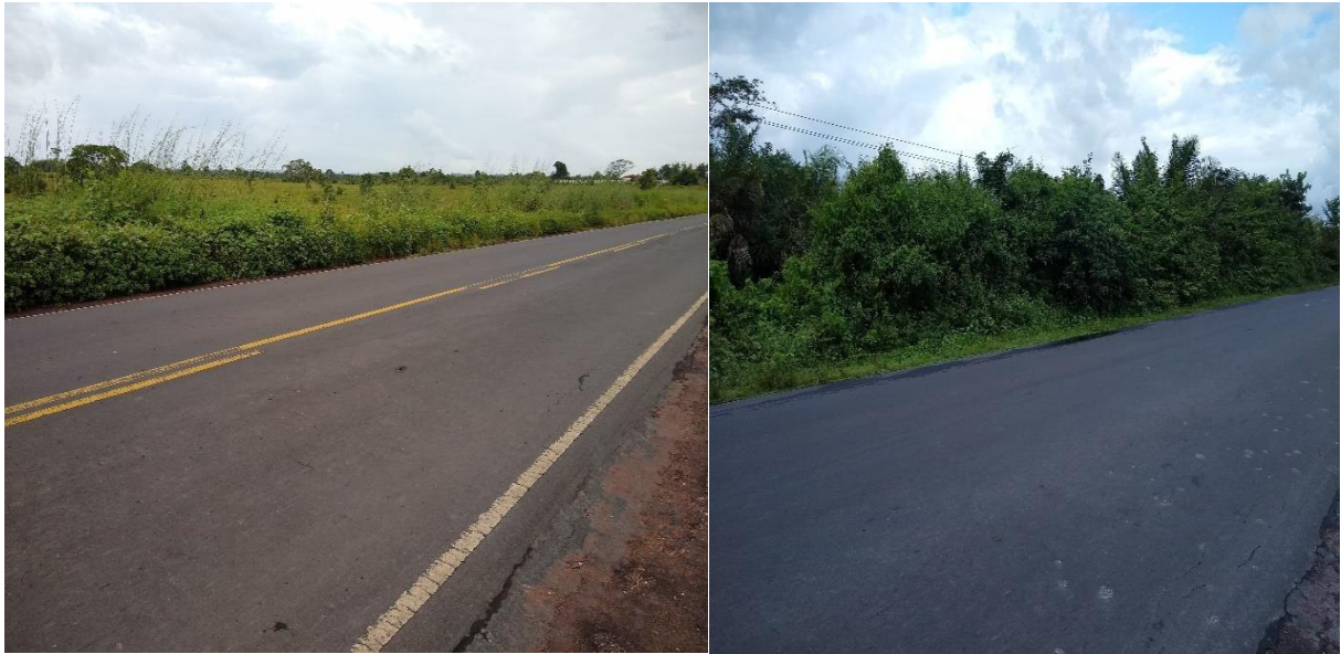
Figura 2 – Vista da MA-106.
