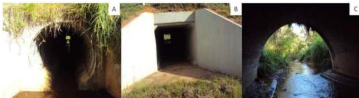
Figura 10 – Exemplos de passagem inferiores tipo túnel na rodovia SP – 225, em Brotas, Brasil.
