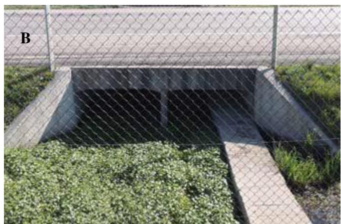
Figura 9 – Exemplos de passagem para fauna, A) passagem tipo caixa; B) Passagem de fauna subterrânea mista na rodovia BR-392/RS.
