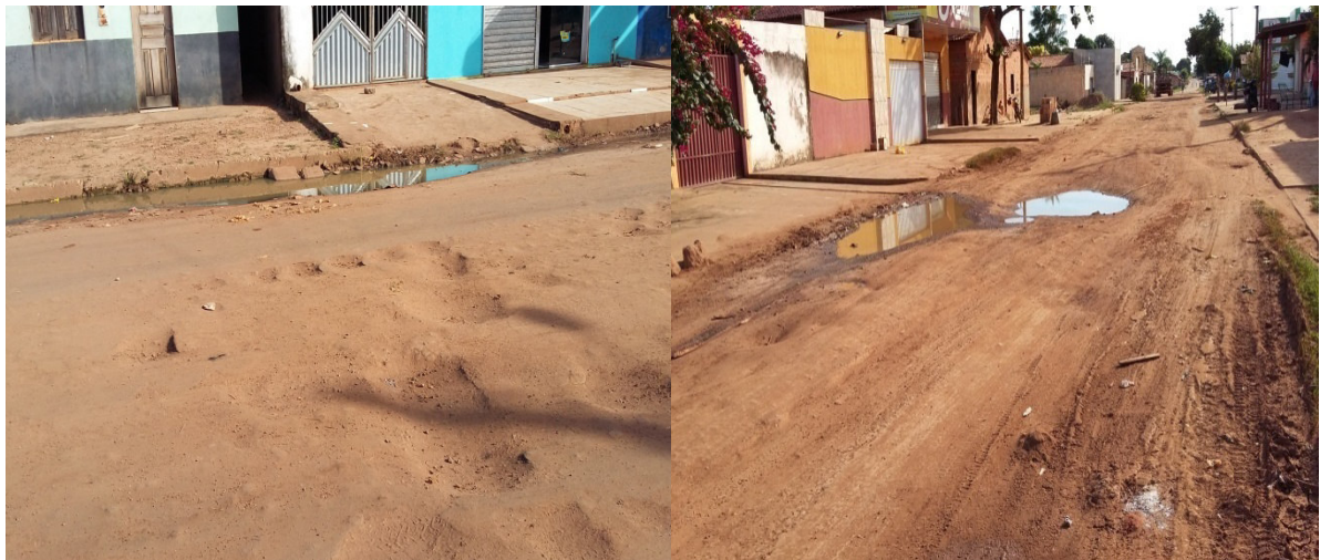
Figura 2 – Águas pluviais e esgotos nas ruas do bairro Vilinha
