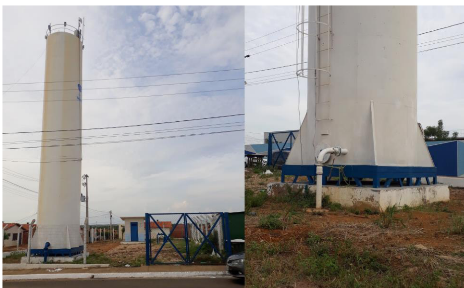
Figura 4 – Reservatório de água metálico tubular alto.
