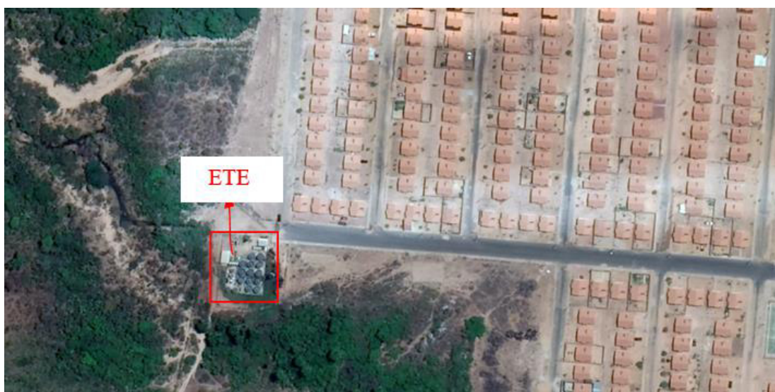
Figura 3 – Estação de Tratamento de esgoto do Residencial Veneza.
