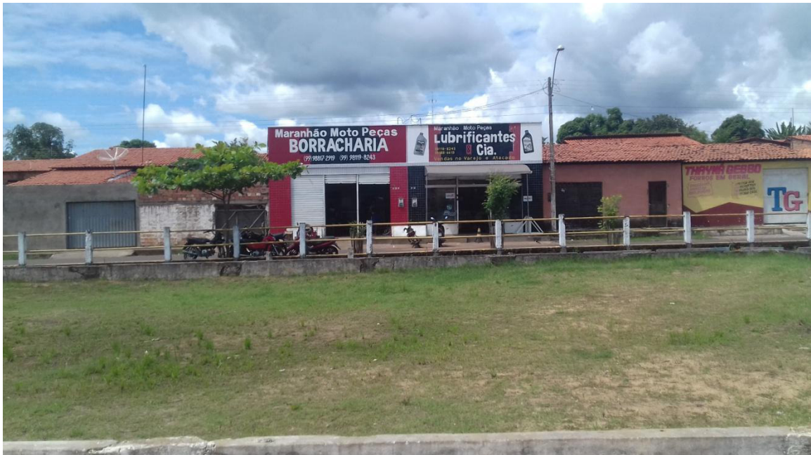
Figura 05. Oficina instalada ao lado do “Riacho Água Fria”.
