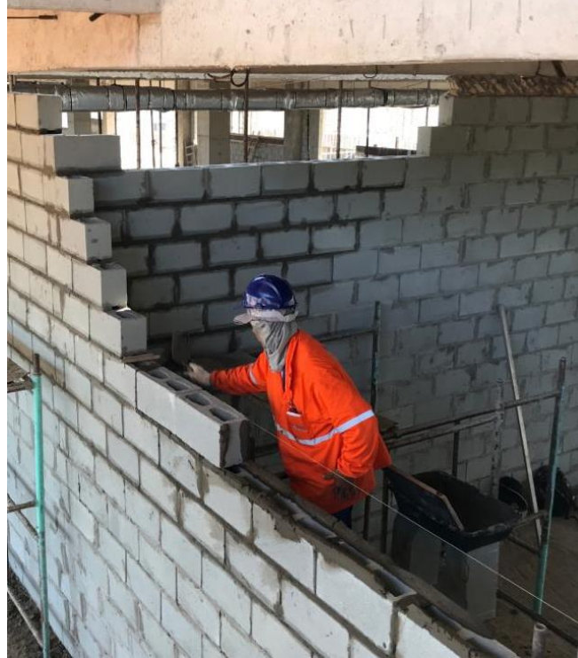
Figura 37 – Execução do serviço de alvenaria na obra
