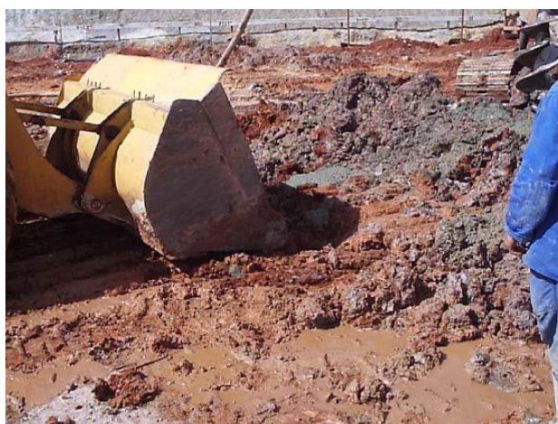
Figura 8 - Retirada do solo para fora da área de trabalho.
