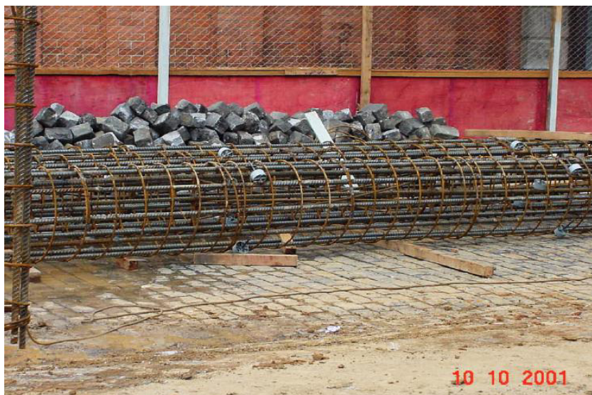
Figura 21 - Armadura utilizada em estacas hélice contínua.
