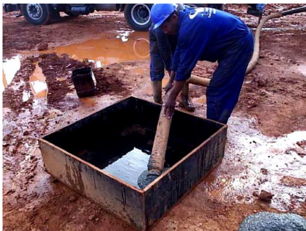
Figura 17 - Realização do ensaio para calibração da bomba de concreto.
