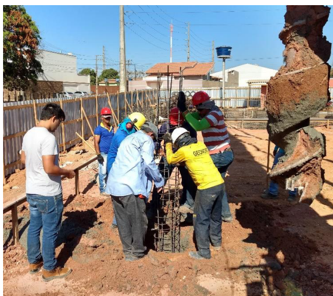
Figura 9 - Instalação manual de armadura.
