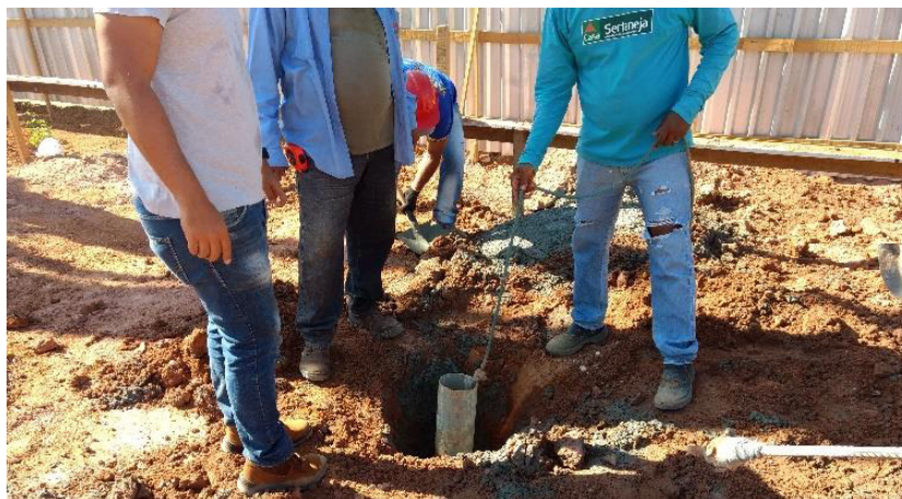
Figura 18 - Retirada de concreto excedente até a cota de arrasamento.
