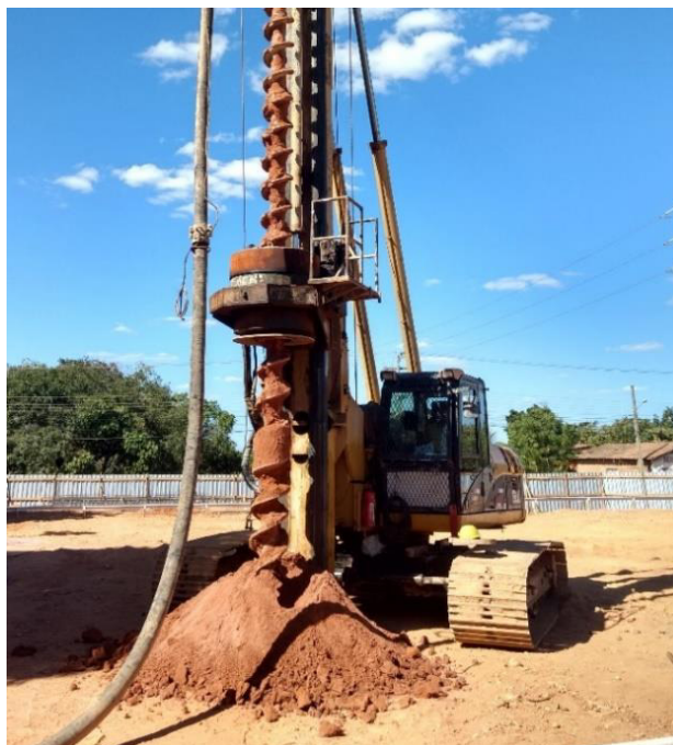
Figura 5 - Perfuração da estaca.
