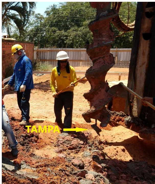
Figura 6 - Detalhe da tampa metálica provisória.
