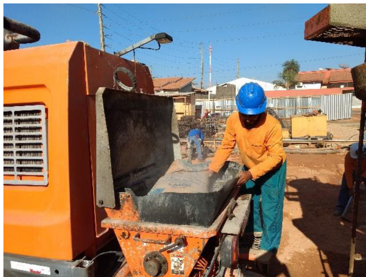
Figura 19 - Calda de lubrificação sendo preparada dentro do cocho da bomba.
