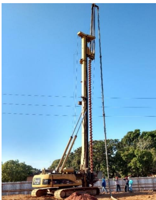
Figura 11 - Perfuratriz Hélice Contínua EM800/24.
