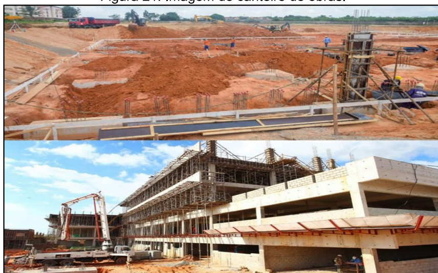
Figura 21: Imagem do canteiro de obras.
