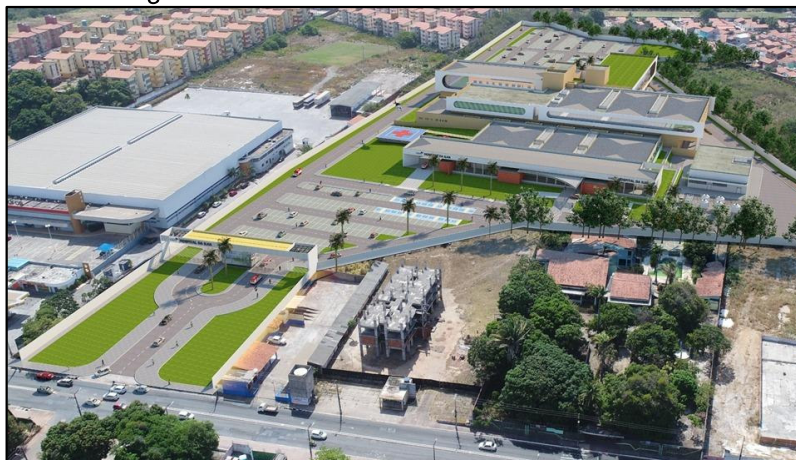
Figura 20: Vista humanizada da obra estudada.
