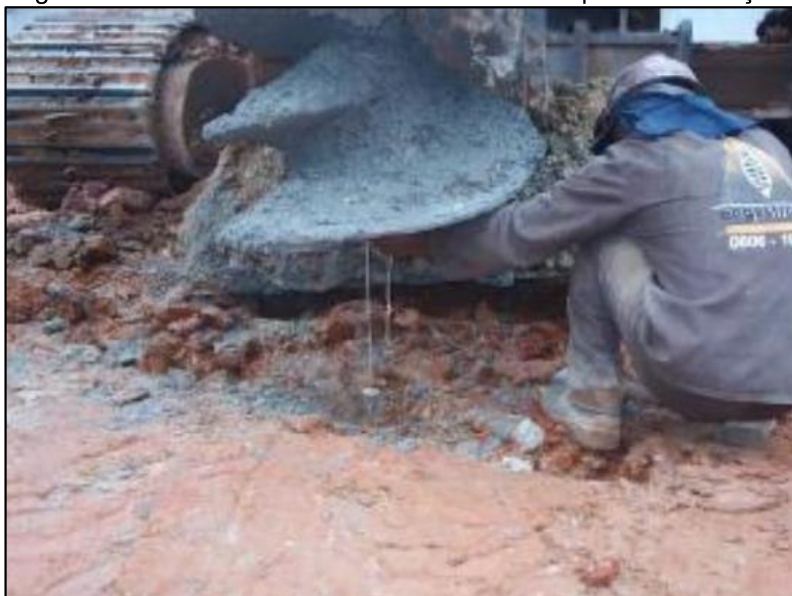
Figura 11: Posicionamento do eixo da hélice no ponto de locação.
