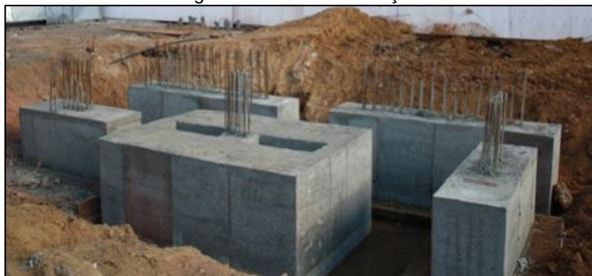
Figura 4: Blocos de fundação.
