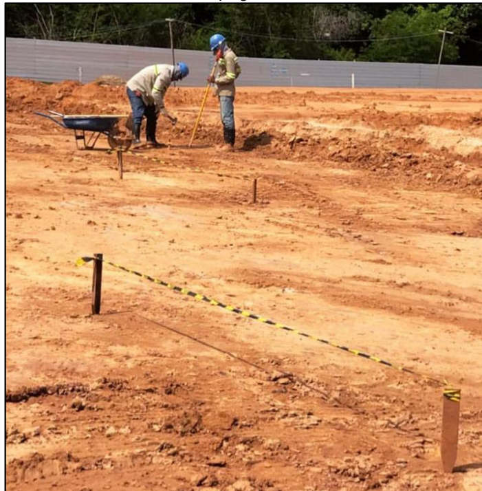
Figura 10: Levantamento topográfico e locação de eixos das estacas realizado pela equipe de topografia.
