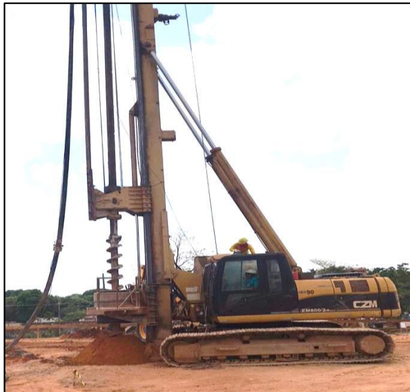
Figura 13: Perfuratriz de esteira utilizada na obra estudada.
