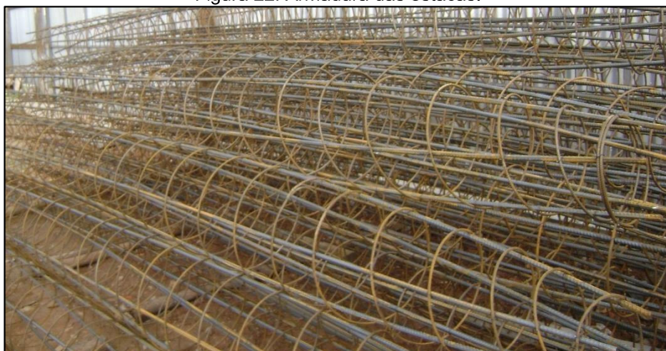
Figura 22: Armadura das estacas.
