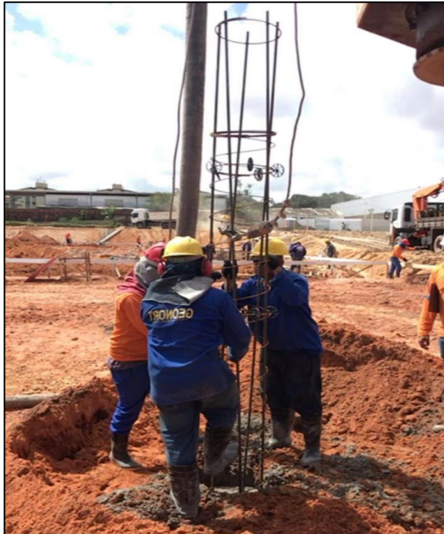
Figura 17: Equipe de colaboradores auxiliando na colocação da armadura da estaca que foi erguida pelo guindaste da perfuratriz.
