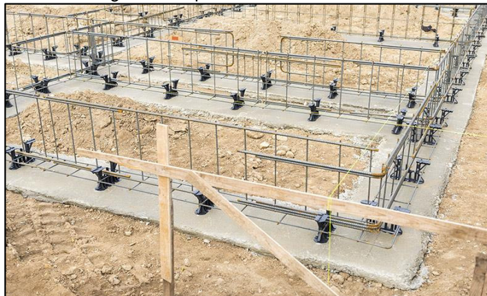
Figura 6: Sapata corrida ou baldrame.
