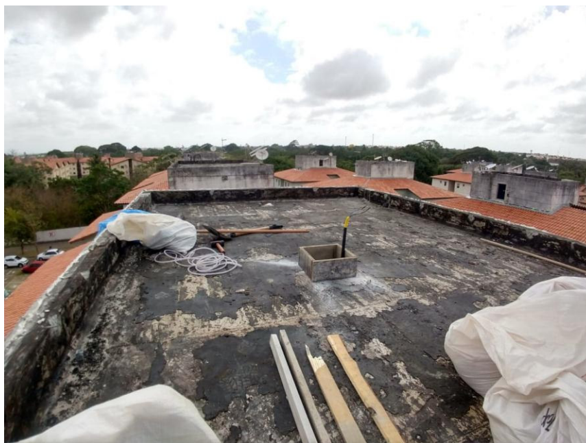
Figura 29 – Retirada da manta danificada
