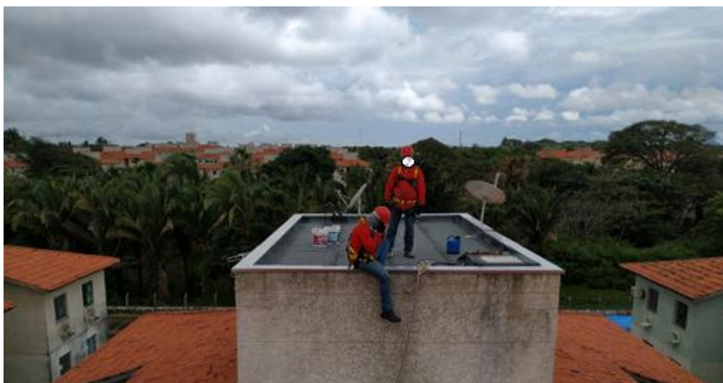
Figura 33 – Aplicação do rufo metálico sobre alvenaria da cobertura
