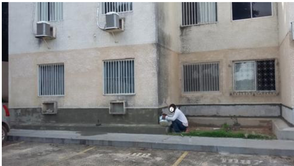
Figura 38 – Aplicação de Viaplus em 2 demãos
