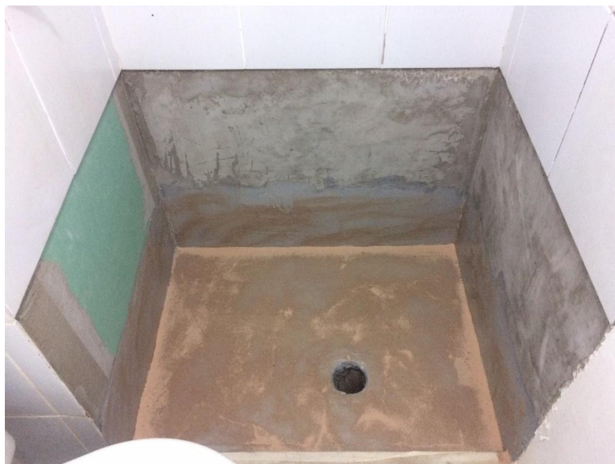
Figura 15 – Aspersão de areia
