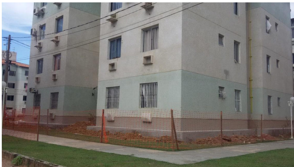
Figura 39 – Aplicado emboço
