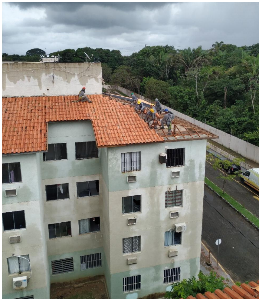
Figura 27 – Substituição e reposicionamento das telhas
