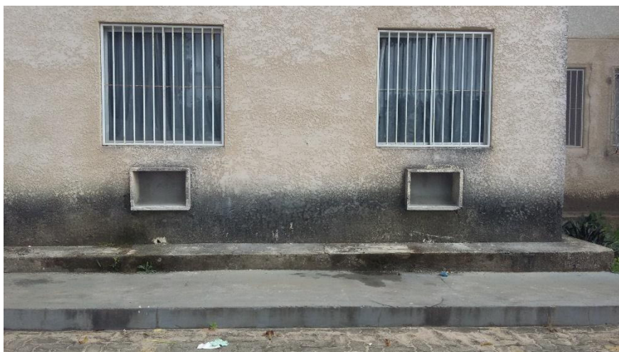
Figura 22 - Acabamento de argamassa na caixa de ar condicionado
