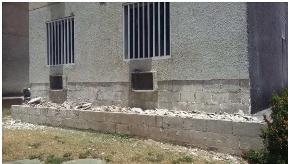
Figura 36 – Retirada do revestimento externo
