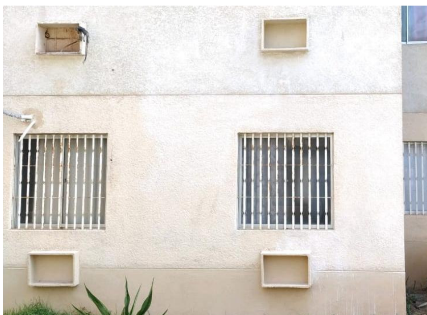
Figura 23 - Pintura ar condicionado
