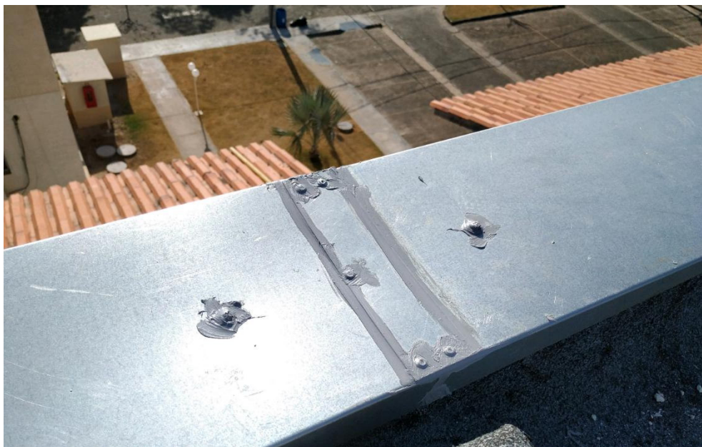
Figura 34 – Aplicação de silicone nas juntas e nos parafusos
