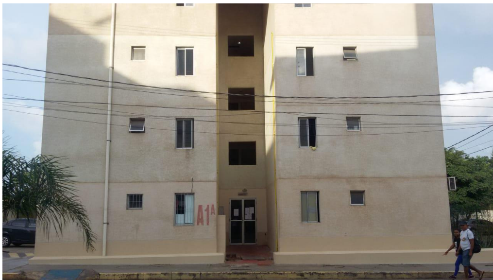
Figura 40 – Aplicação da pintura Ibratin área calçada
