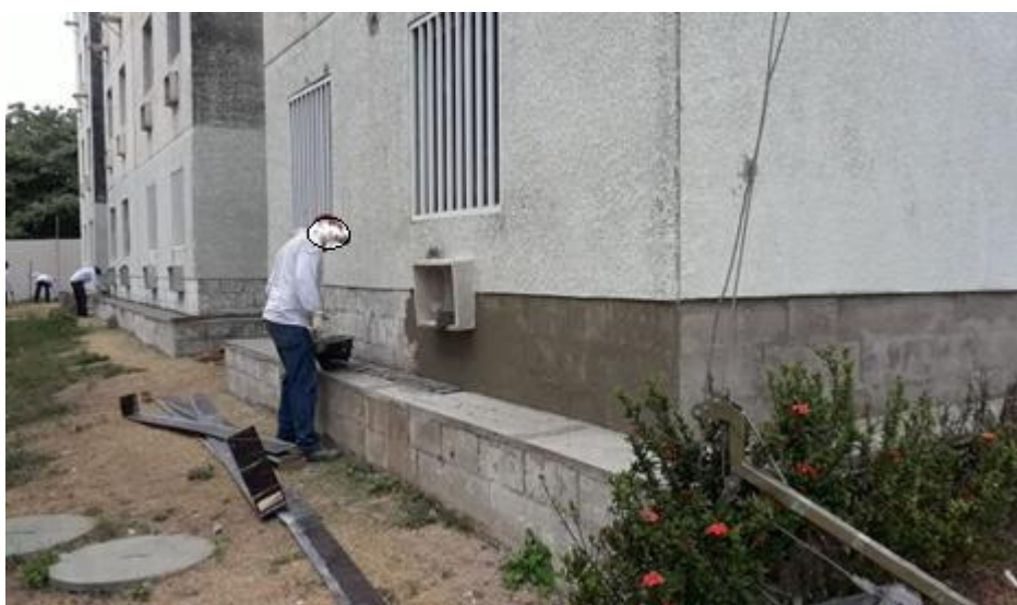
Figura 37 – Regularização da área externa
