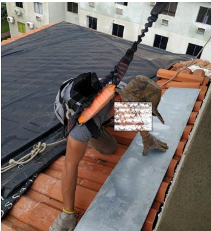
Figura 28 – Aplicação do furo no telhado
