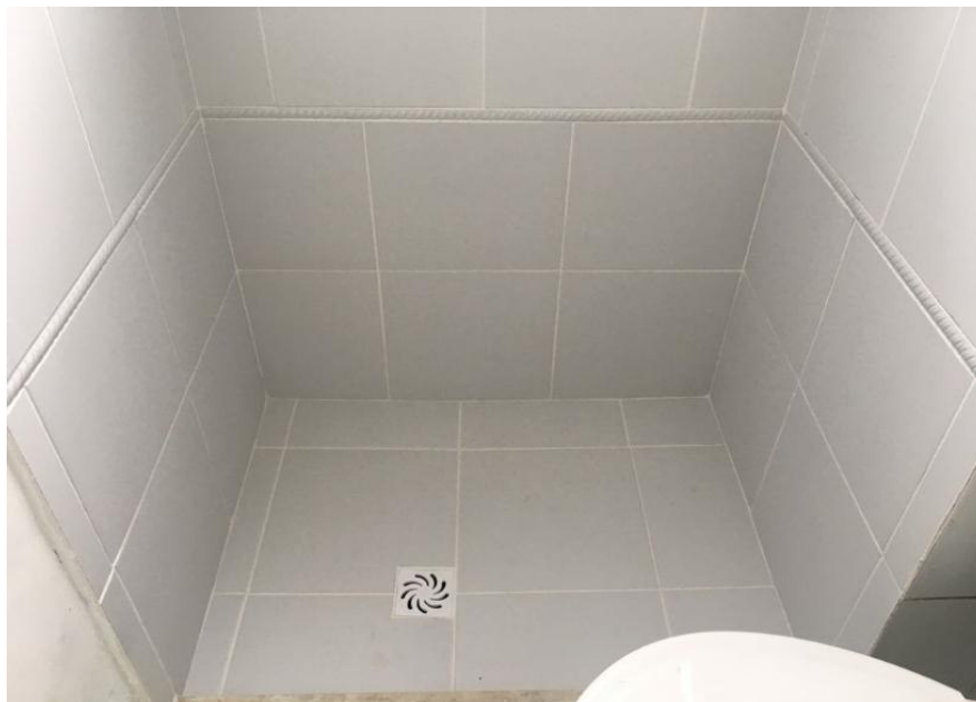
Figura 16 – Assentamento do rodapé e cerâmica
