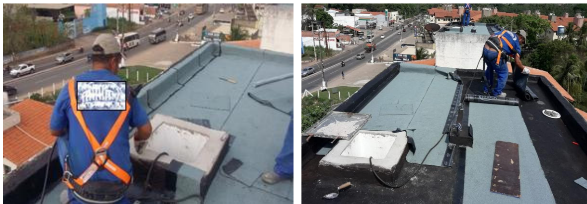
Figura 32 – Aplicação da manta ardosiada
