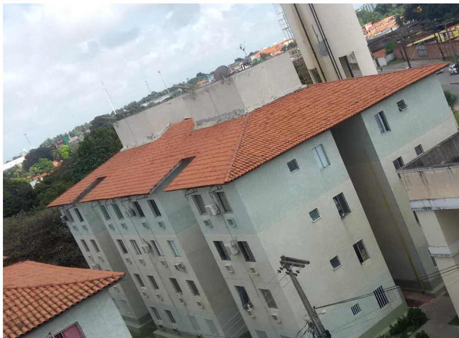
Figura 26 – Manta no vão do telhado
