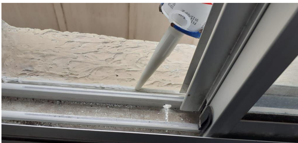
Figura 19 - Aplicação do selante de silicone
