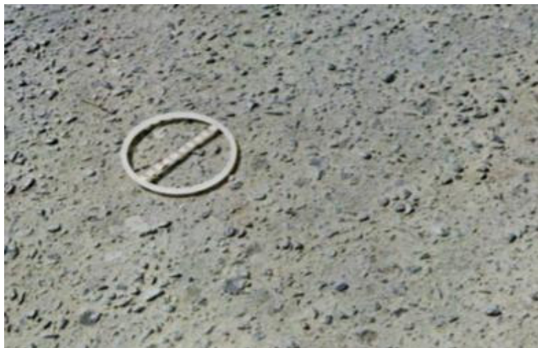
Figura 16: Desgaste (D)
