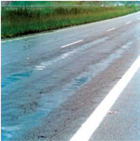
(a) Afundamento por consolidação em trilha de roda (ATC)
