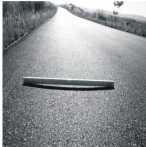
(b) Afundamento por consolidação localizada (ALC)
