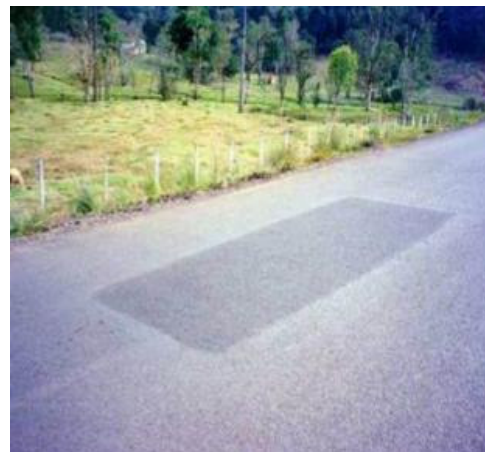
(b) Remendo (boa execução)
