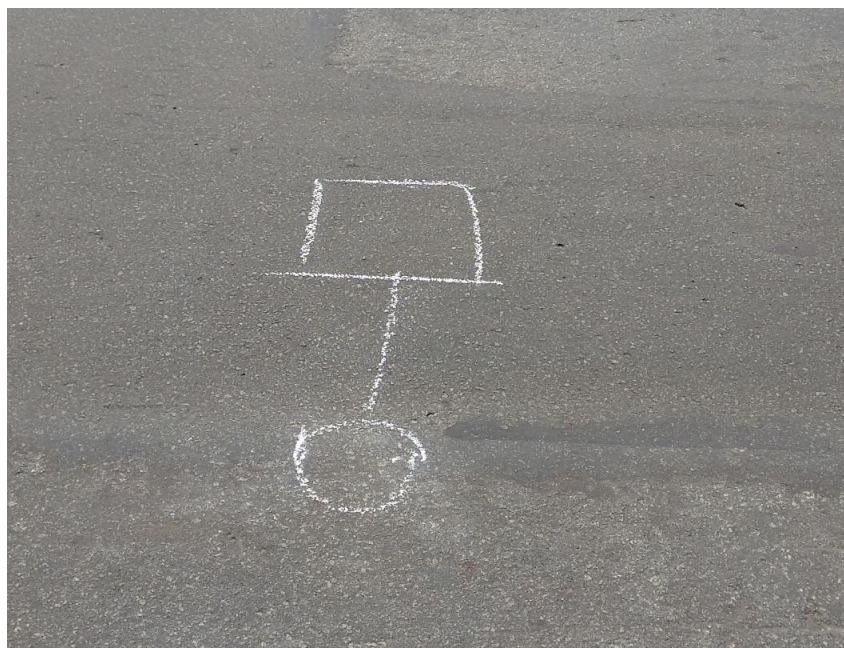
Figura 22: Demarcação de estaca
