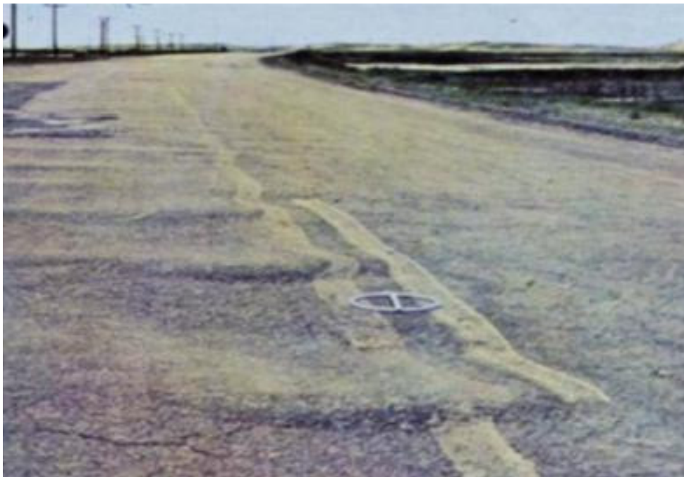
Figura 13: Ondulação (O)
