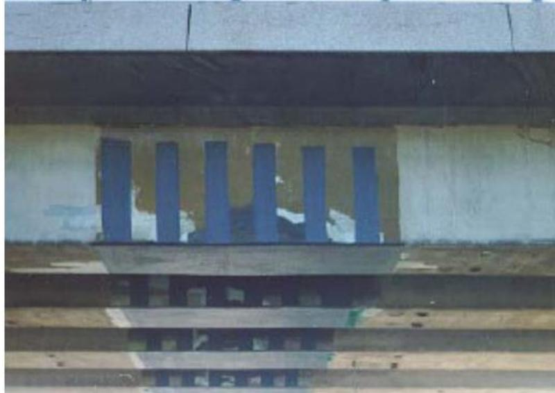
Figura 15 – Reforço de ponte à força cortante com utilização de fibras de carbono (SILVA FILHO, 2007)
