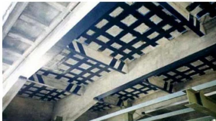
Figura 16 – Reforço de Lajes à flexão e Vigas à flexão e a força cortante com tecidos de fibras de carbono (SILVA FILHO, 2007).
