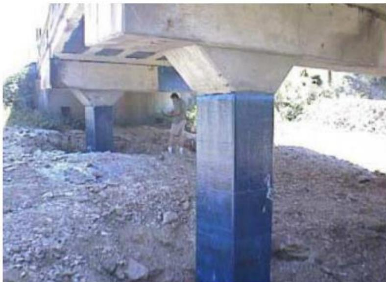
Figura 14 – Pilares com aplicação da fibra de carbono (SILVA FILHO, 2007)
