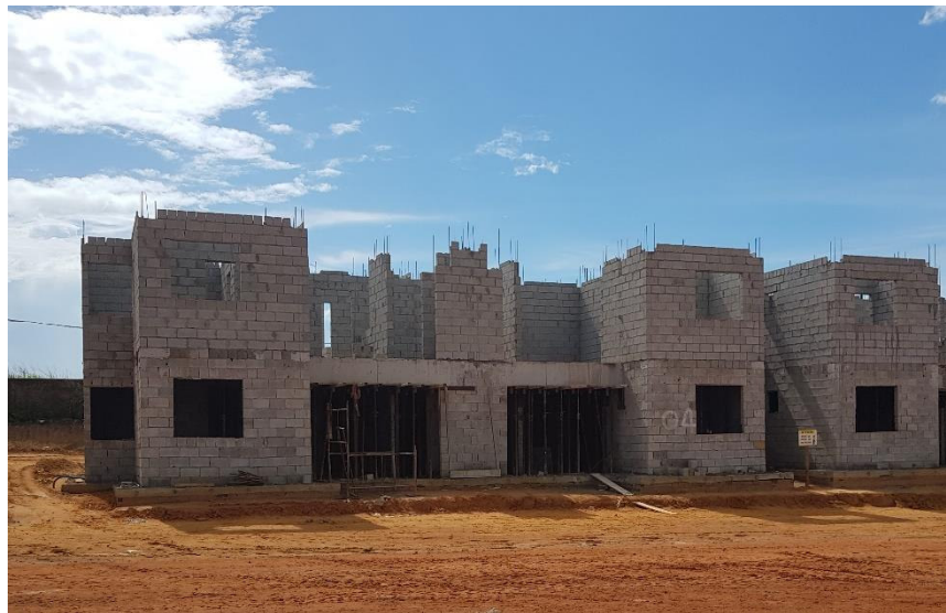
FIGURA 8 – Canteiro de obra
