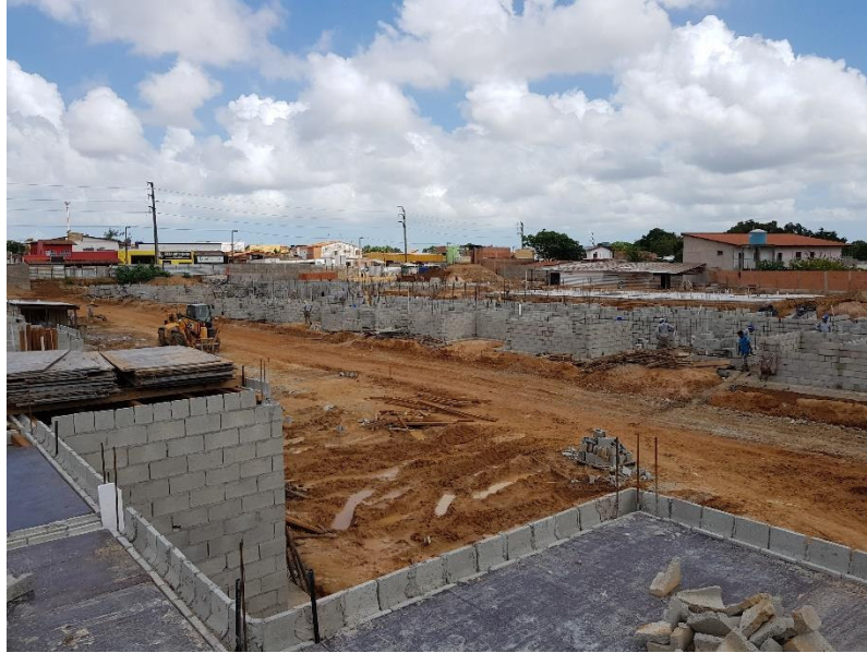
FIGURA 7 – Canteiro de obra
