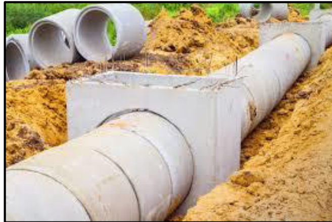
Figura 7 - Tubos de Concreto
