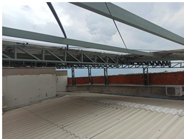
Figura 16 – Contraventamento em forma de “X”.
