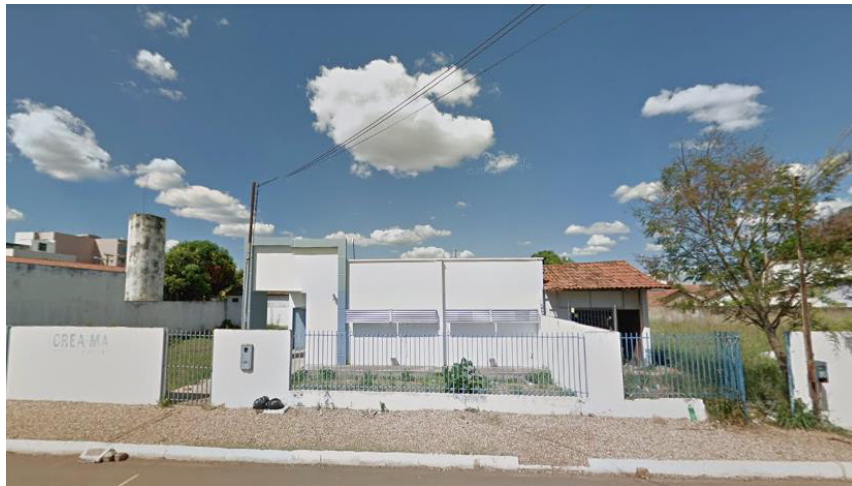
Figura 08 – Sede CREA em Balsas
