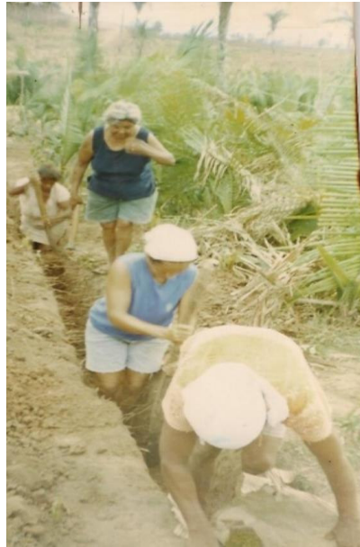
Figura 11: Mulheres trabalhando na construção da AQCBSJB
