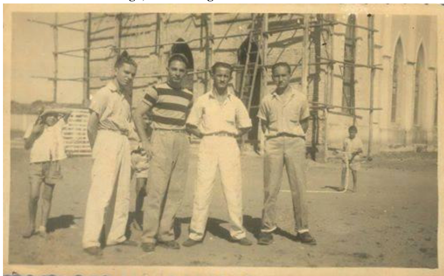
Figura 3: Construção da Nova Igreja São Sebastião. Da esquerda para a direita: Mário Veiga, Haroldo Veiga, Durval Lago e Clóvis Godinho
