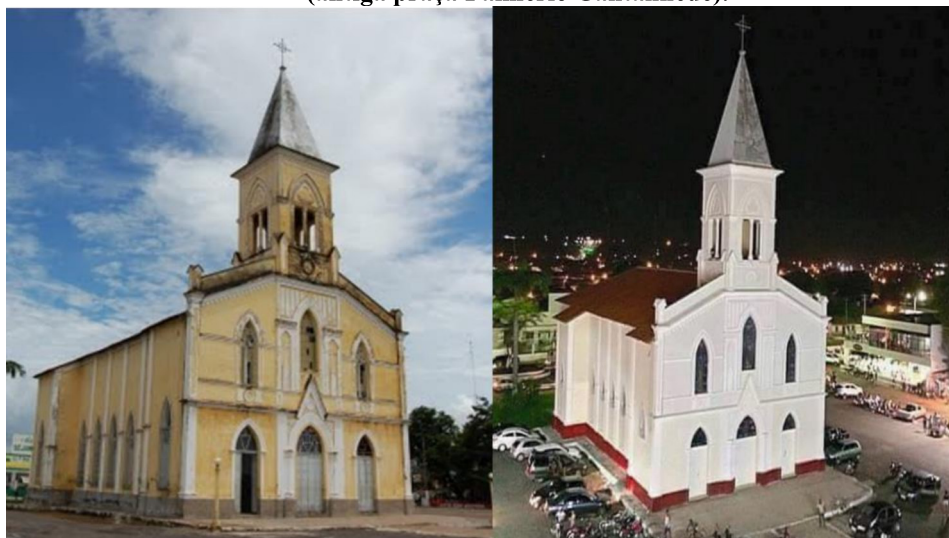
Figura 4: Igreja São Sebastião antes e depois da reforma de 2012 respectivamente, praça São Sebastião (antiga praça Palmério Cantanhede).
