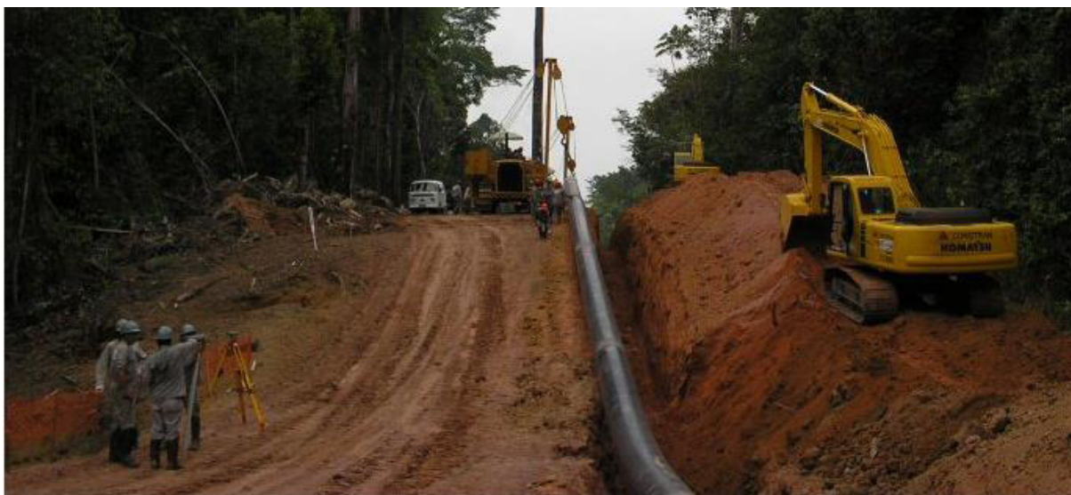
Figura 3 – Instalação e abaixamento da tubulação do mineroduto.
