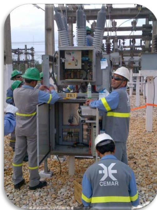
Figura 5.6 – Grupo Autônomo trabalhando na limpeza de um religador na SE IPA
