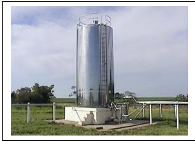
Figura 03 – Reservatório Fonte: MARIBÁ, 2011
