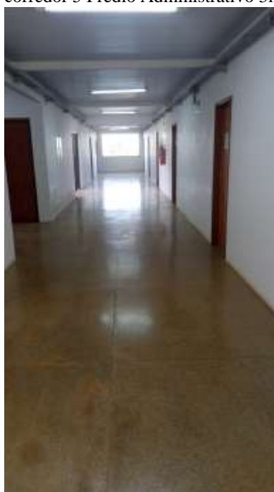
Figura 62: corredor 5 Prédio Administrativo 3m de largura.
