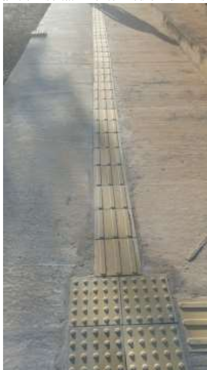
Figura 49: Piso tátil frente Prédio Administrativo.
