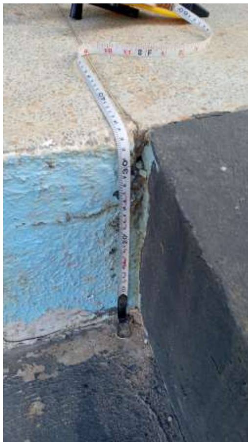
Figura 27: Altura rampa 1 Prédio pedagógico.
