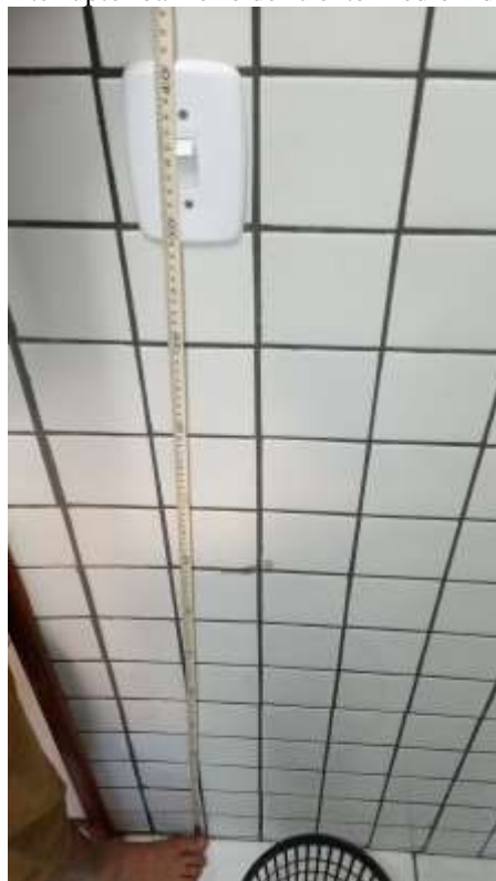
Figura 54: Altura interruptor banheiro deficiente Prédio Administrativo 1,45m.
