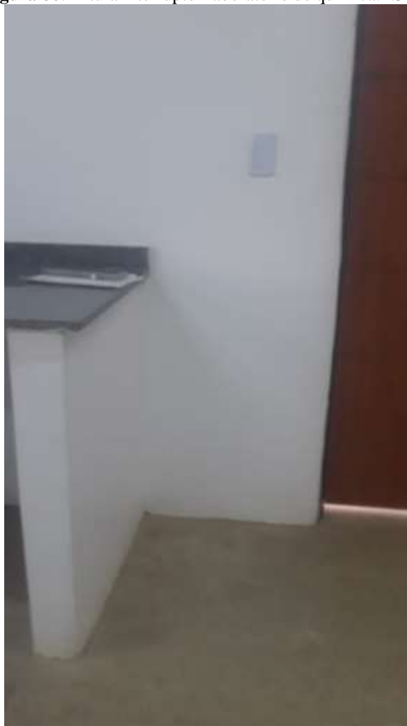
Figura 86: Altura interruptor laboratório de química:1.30m.
