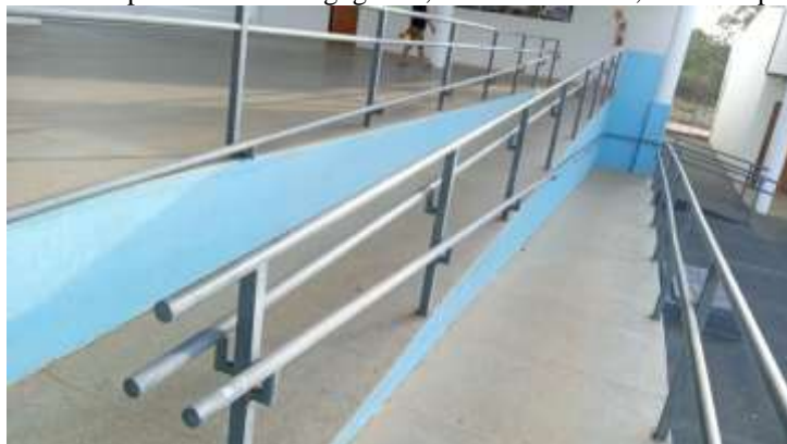
Figura 37: Rampa 3 Prédio Pedagógico 1,5m de altura x 13,92m de hipotenusa.
