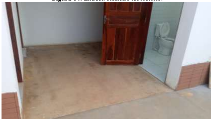
Figura 84: Entrada banheiro laboratório.
