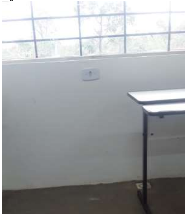
Figura 100: Altura tomada saneamento ambiental:0.90m.
