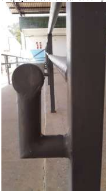
Figura 31: Espaçamento entre barras de Apoio: 40 mm
