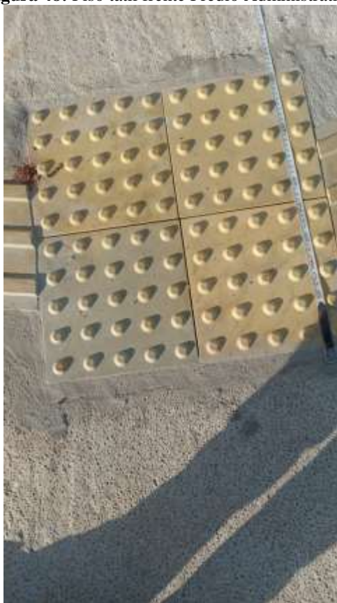
Figura 48: Piso tátil frente Prédio Administrativo.
