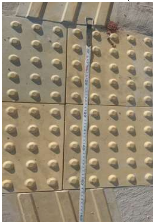
Figura 50: Piso tátil frente Prédio Administrativo 54cm (cada unidade de 27X27).
