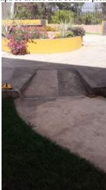
Figura 67: Largura rampa de acesso área de lazer próximo à biblioteca: 1.27m
