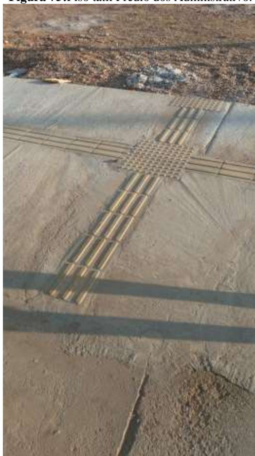
Figura 75: Piso tátil Prédio dos Administrativo.
