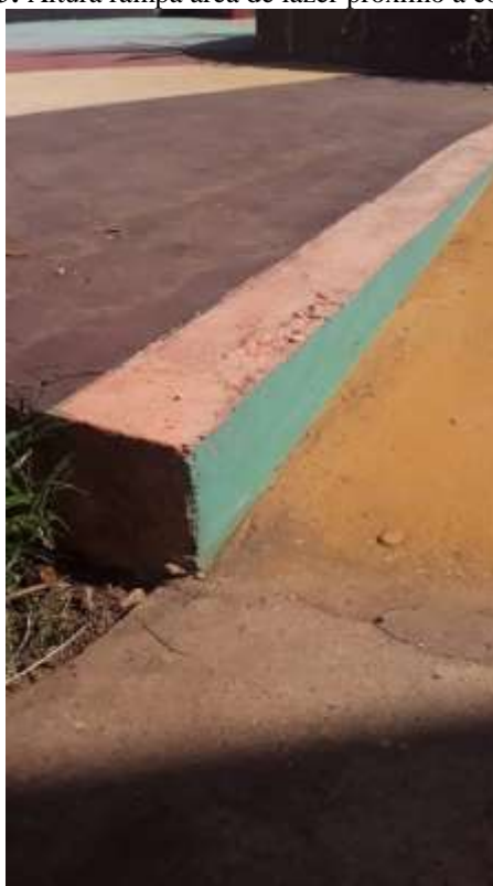
Figura 73: Altura rampa área de lazer próximo a copa: 18cm.
