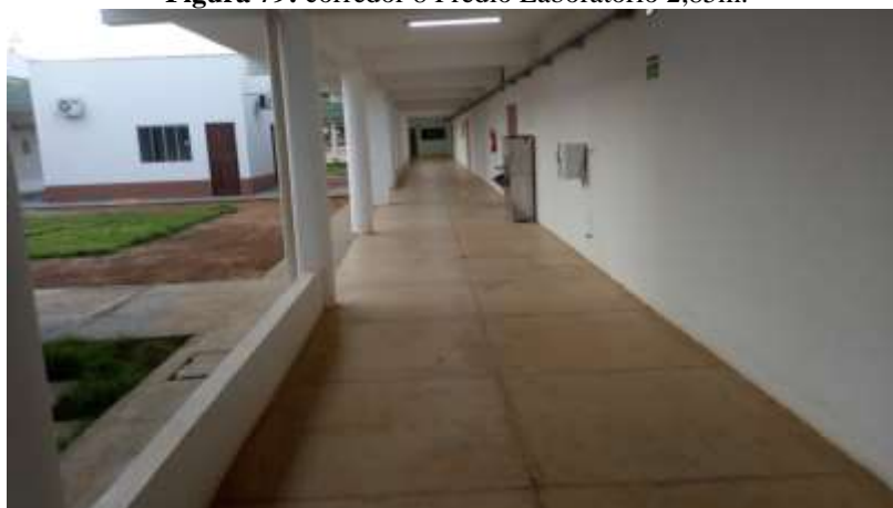
Figura 79: corredor 8 Prédio Laboratório 2,85m.
