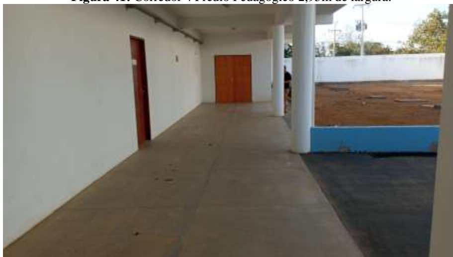
Figura 41: Corredor 4 Prédio Pedagógico 2,95m de largura.
