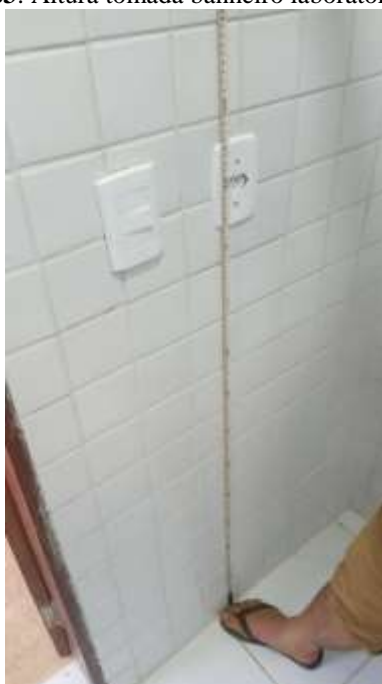
Figura 83: Altura tomada banheiro laboratório 1,20m.
