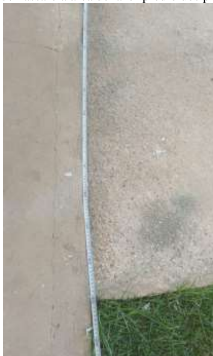
Figura 65: Passarela área de lazer prédio dos professores.
