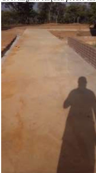
Figura 106: largura calçada prédio laboratório
