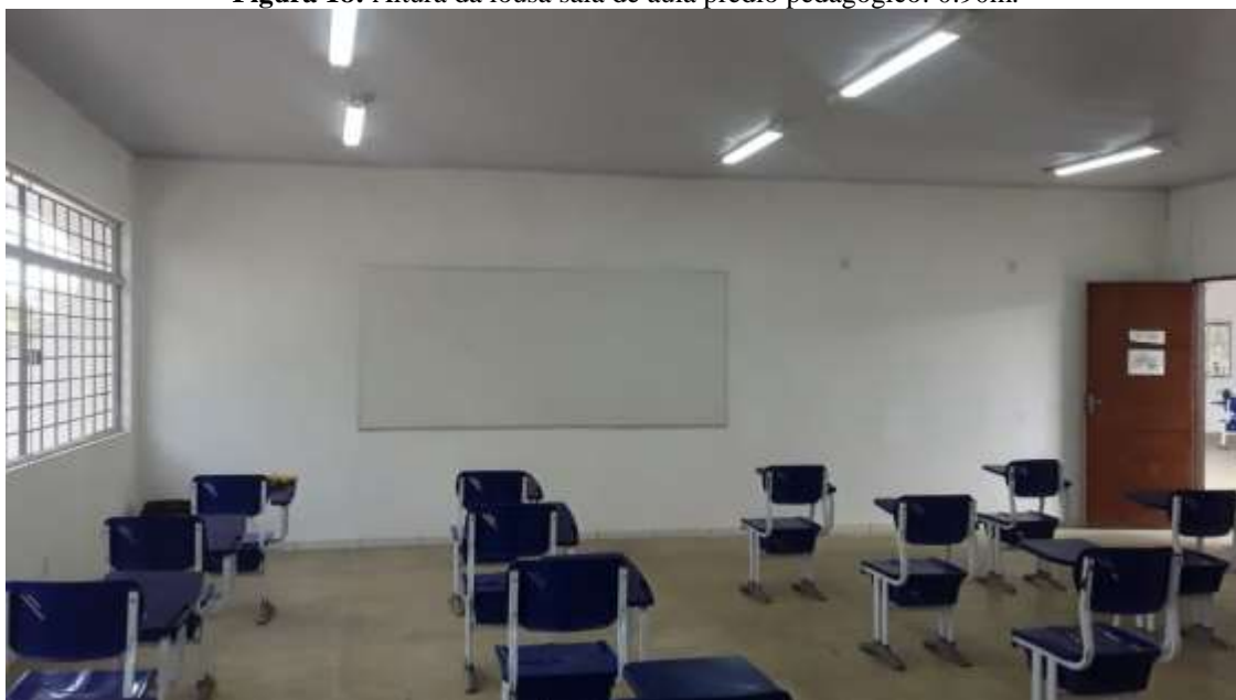
Figura 18: Altura da lousa sala de aula prédio pedagógico: 0.90m.
