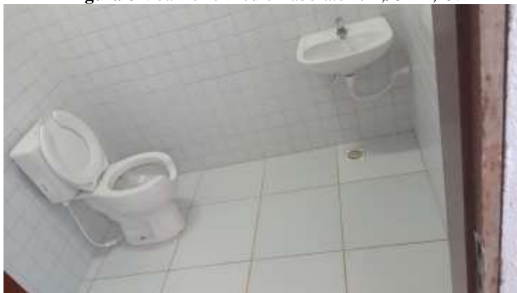
Figura 82: banheiro Prédio Laboratório 1,95 x 1,45.
