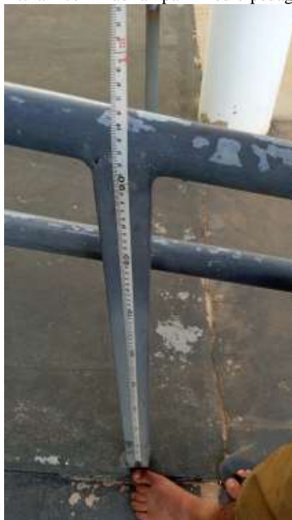
Figura 30: Altura 2 corrimão rampa 1 Prédio pedagógico: 95cm.
