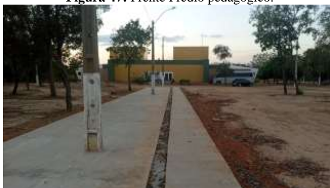
Figura 47: Frente Prédio pedagógico.
