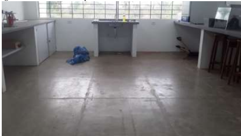
Figura 91: altura balcões e pia Prédio Laboratório Zootecnia Ambiental: 0.93m.
