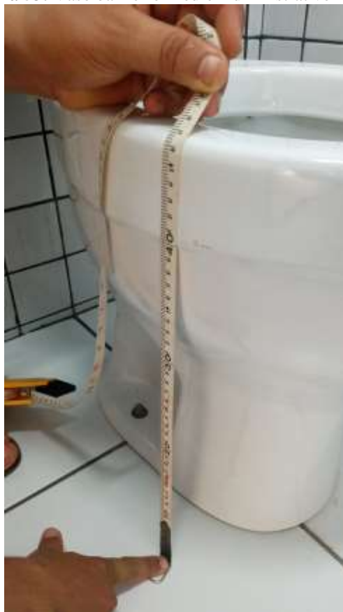
Figura 53: Vaso banheiro Prédio Administrativo 46 cm.
