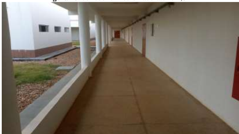
Figura 78: corredor 7 Prédio Laboratório 2,82m.
