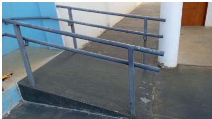
Figura 26: Rampa 1 Prédio Pedagógico 1,18m de largura, 33 cm de altura e 1,98m de comprimento.
