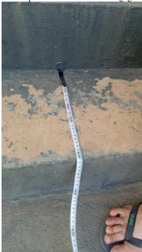
Figura 43: Espelho escada 1 Prédio Pedagógico 31cm.
