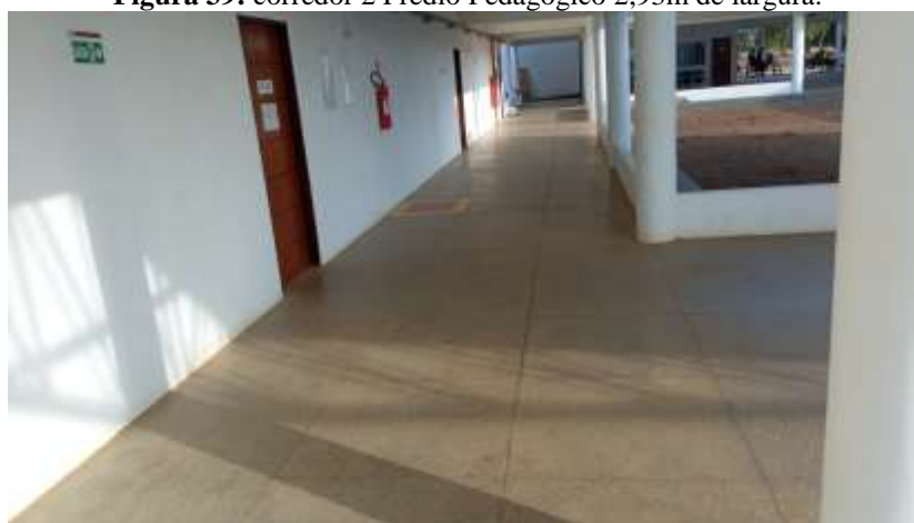
Figura 39: corredor 2 Prédio Pedagógico 2,93m de largura.
