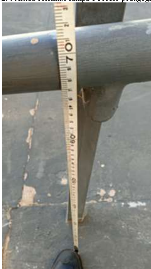
Figura 29: Altura corrimão rampa 1 Prédio pedagógico 70cm
