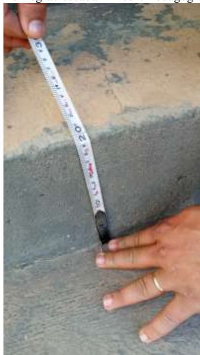
Figura 44: Degrau escada 1 Prédio Pedagógico 20 cm.
