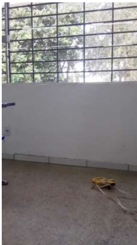
Figura 15: Altura janelas Prédio Pedagógico: 0.95m.
