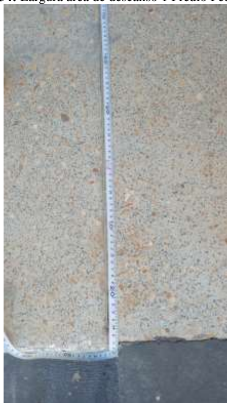
Figura 34: Largura área de descanso 1 Prédio Pedagógico.
