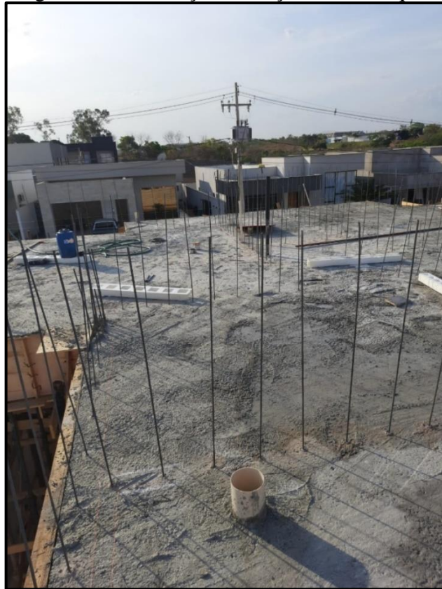
Figura 17 - Perfuração e fixação dos arranques
