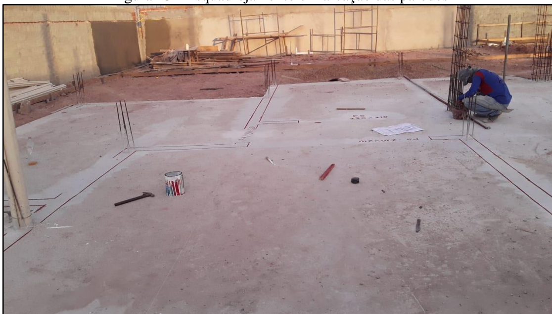
Figura 15 - Esquadrejamento e marcação das paredes
