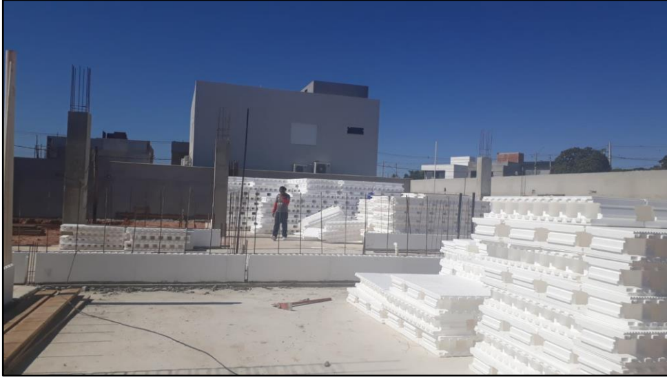
Figura 16 - Levante da primeira fiada
